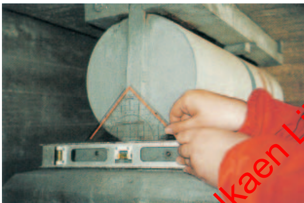
Kuva 52. Rullalaakerin asennon mittaus.
