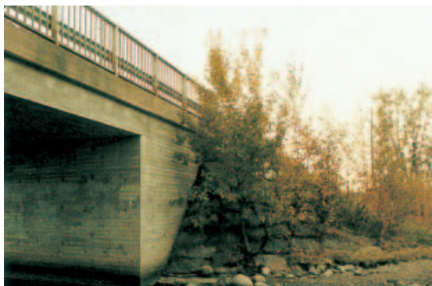
Kuva 144. Puut on poistettava kivikeilasta.
