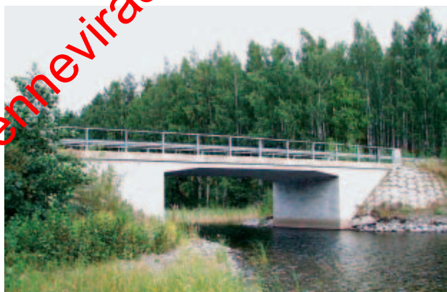
Kuva 9. Laattakehäsilta (Nikinsalmen silta, Ristiina, KaS-2643).
