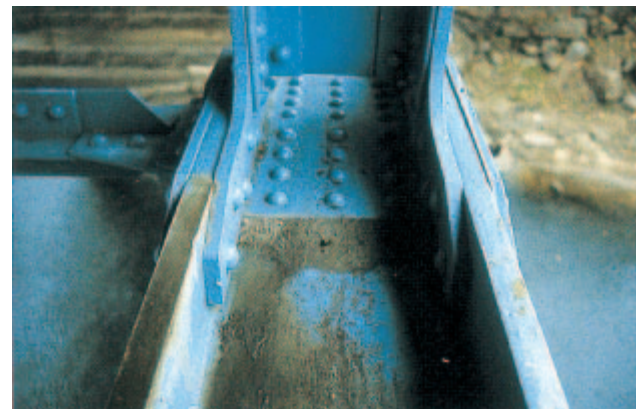
Kuva 93. Esimerkki suunnittelu- ja kunnossapitovirheistä, kun maa-ainekset kerääntyvät rakenteen päälle ja niitä ei ole poistettu.
