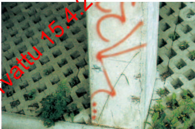
Kuva 89. Teräskorroosion aiheuttama halkeama pilarin kulmassa.
