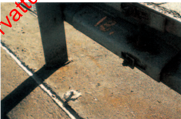
Kuva 43. Juottamalla kiinnitetty tarkkailupiste.
