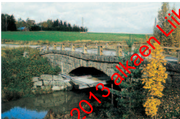
Kuva 106. Jos holvin muoto ei ole oikea, on havaittava holvin vahventamista.
