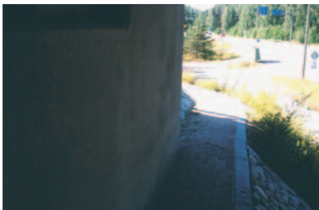
Kuva 76. Hyvä tarkastustasanne.
