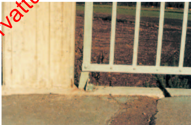
Kuva 100. Taaksepäin kallistunut maatuki.
