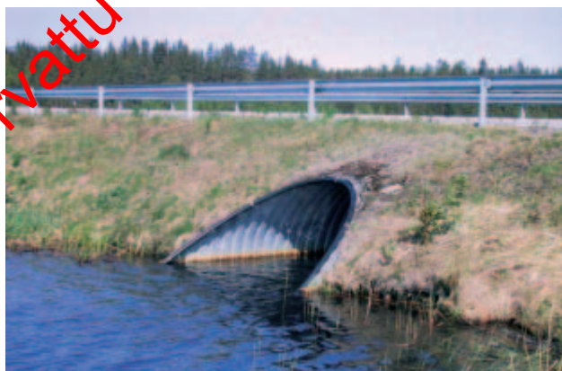
Kuva 12. Teräksinen putkisilta (Salmiahon silta, Evijärvi, V-5258).
