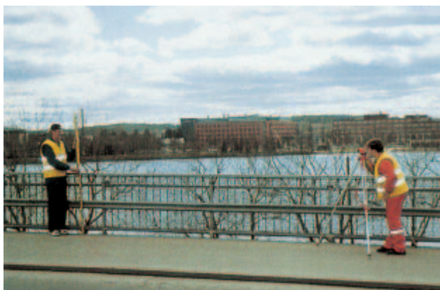
Kuva 50. Vaaitusta sillan kannella.
