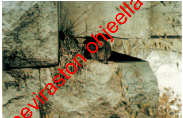
Kuva 113. Maata ja kasvillisuutta laakeritasolla.
