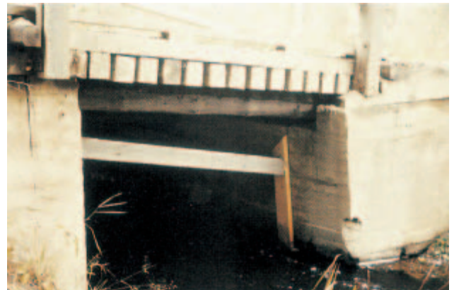
Kuva 102. Perusmaan eroosion vuoksi painunut maatuki.
