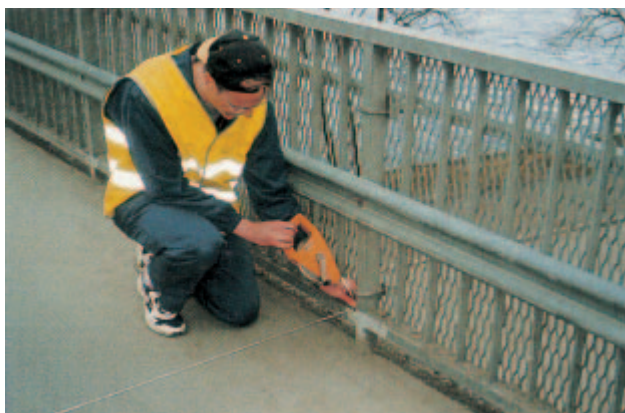
Kuva 45. Kaidevälin mittaus mittanauhalla.
