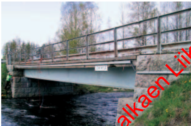
Kuva 11. Teräksinen palkkisilta (Pyhäjoen silta, Pyhäsalmi, O-3272).
