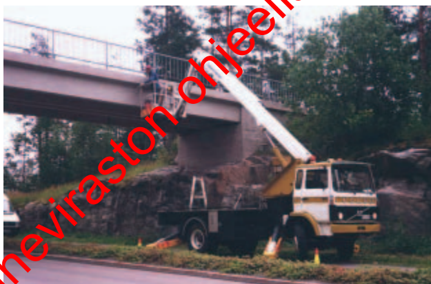
Kuva 74. Henkilönostin on usein tarpeellinen apuväline.
