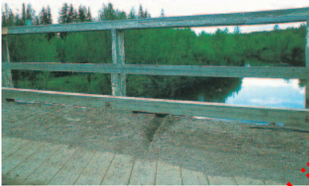
Kuva 126. Paksu sorakerros puukannen päällä.
