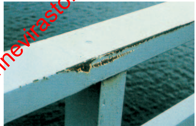
Kuva 140. Kunnossapitomaalaus tehdään tarvittaessa paikkausmaalauksena.
