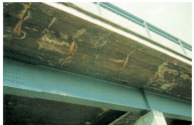
Kuva 122. Kansilaatan vesivuoto.
