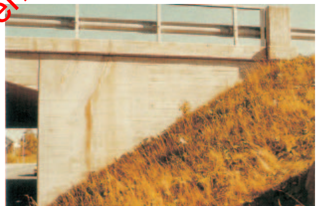
Kuva 105. Halkeaman syy on aina pyrittävä selvittämään.
