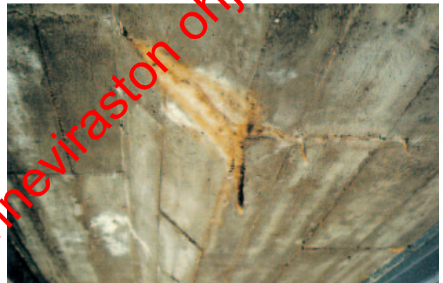
Kuva 84. Kalkkipuikkoja halkeamassa.
