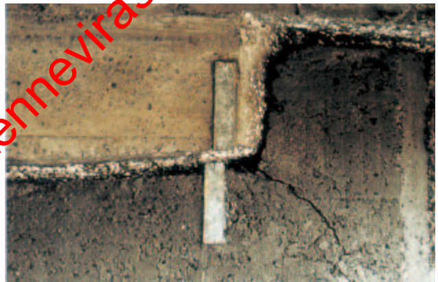
Kuva 53. Alumiiniliuskat osoittavat maatuessa tapahtuneen liikkeen.
