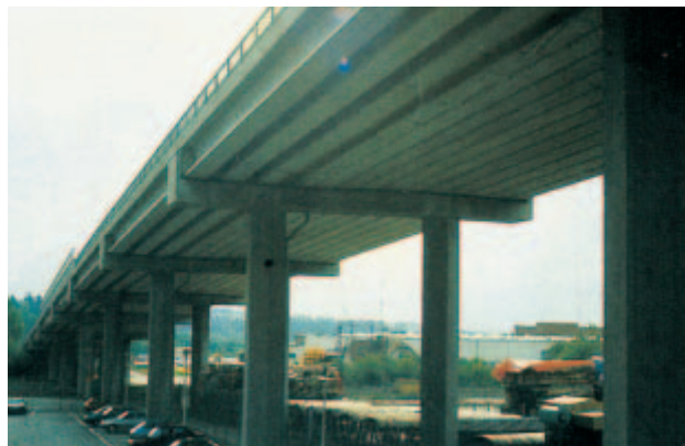
Kuva 10. Elementtirakenteinen jännitetty betoninen palkkisilta (Upon risteys ja ylikulkusilta, Lahti, H-4756).
