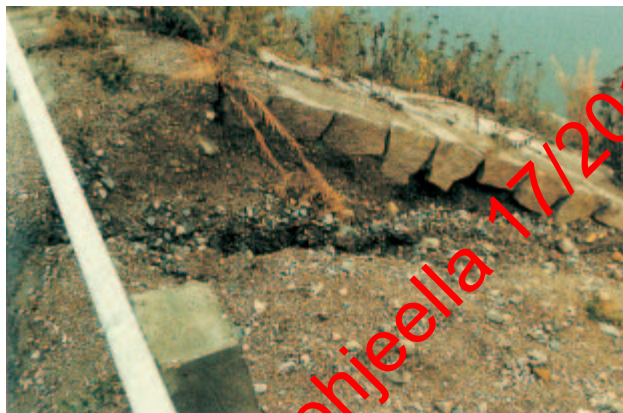
Kuva 142. Eroosioaurio keilan takana
