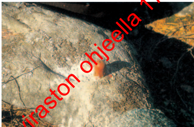
Kuva 44. Kiintopisteet kiinnitetään kutistumattomalla juotoslaastilla.
