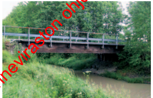
Kuva 13. Puinen liimattu palkkisilta (Palokorven silta, Somero, T-888).
