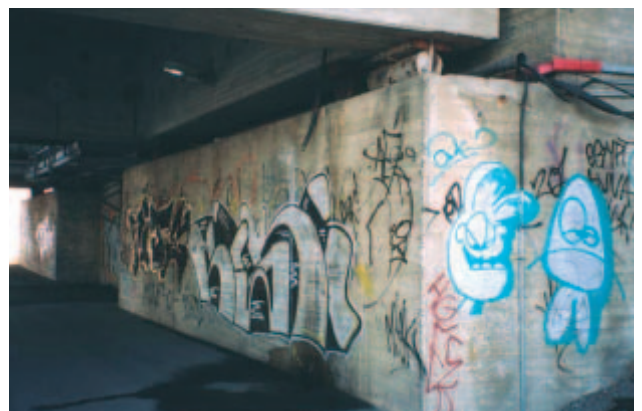
Kuva 148. Siltaa rumentavia töherryksiä.
