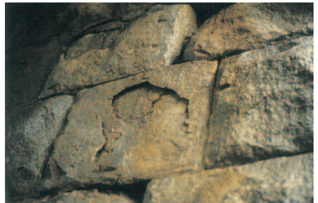
Kuva 96. Jos kivissä on pintalustia, pitää veden valuminen pinnoille estää.
