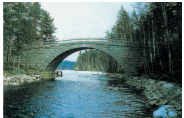
Kuva 14. Kivinen holvisilta (Aunessilta, Tampere, H-389).
