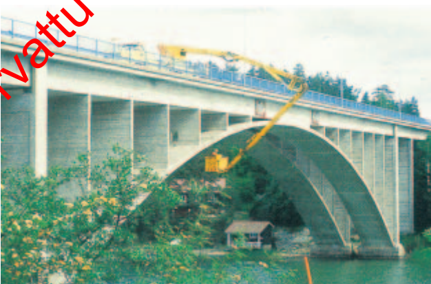
Kuva 73. Siltakurjesta käsin voidaan työskennellä päällysrakenteen alla.
