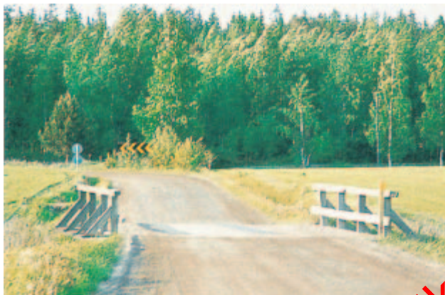
Kuva 99. Vinot sillat pyrkivät kiertymään.
