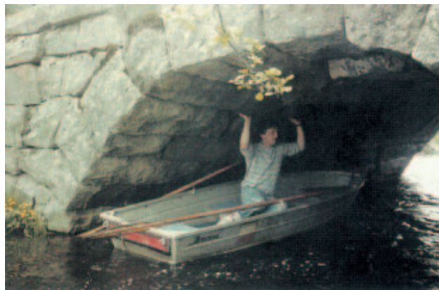
Kuva 75. Vesistösilan tarkastuksessa voidaan käyttää venettä.
