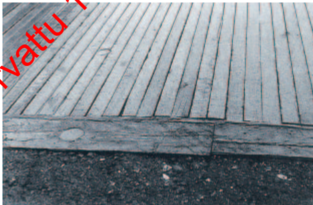
Kuva 95. Ravistunut lankkukansi.
