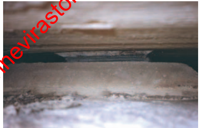
Kuva 135. Kumilevy-laakerin pintakumi on alkanut murtua (pykiä).
