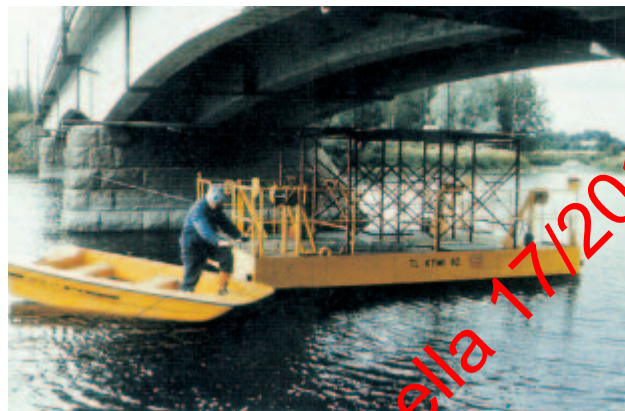
Kuva 77. Kätevä lautta, joka on kiinnitetty haruksilla rantaan.
