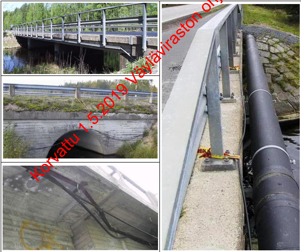
Kuva 18 Ylhäällä vasemmalla sillan johdot ja kaapelit ovat asianmukaisessa kunnossa (A), mutta muiden siltojen osalta ainakin osa siltoihin kiinnitetyistä johdoista tai kaapeleista repsottaa ja roikkuu, joten vuositarkastusmerkintä tulee D-sarakkeeseen.
