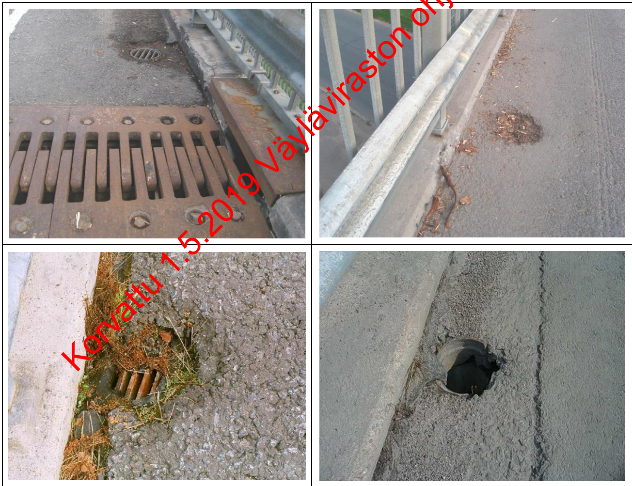
Kuva 14 Ylärivissä vasemmanpuoleinen syöksytorvi on kunnossa, mutta samassa sillassa oleva toinen syöksytorvi on tukossa (ylärivissä oikealla). Tällöin vuositarkastusmerkintä tulee sarakkeeseen B, ja lisätietoihin kannattaa kirjata, mitkä sillan lukuisista syöksytorvista on puhdistettava. Alarivissä vasemmalla vuositarkastaja ehdottaa toimenpiteeksi puhdistusta (B) ja oikealla korjausta (D).
