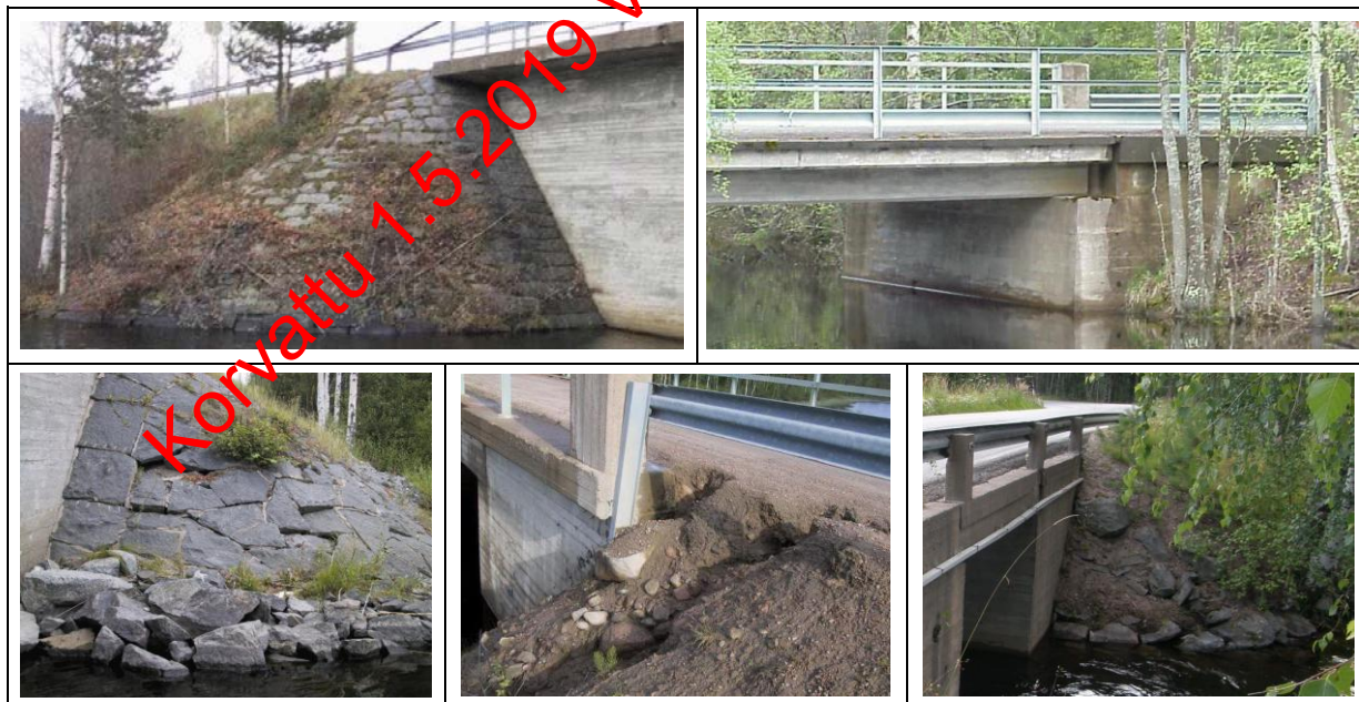
Kuva 22 Ylärivissä vasemmalla sillan keila pitää puhdistaa (B). Ylärivissä oikealla sillan keilat on puhdistettava vesakosta (B), mutta keilan puuston vuoksi vuositarkastusmerkintä tulee myös D-sarakkeeseen. Alarivissä vasemmalla on alle 2 m 2 :n purkautuma (C). Alarivissä keskellä on paha eroosioaurio, joka vaarantaa liikenneturvallisuuden, joten välittömästi ilmoitus tilaajalle ja merkintä D-sarakkeeseen. Alarivin oikeanpuoleisimmassa sillassa keila vaatii puhdistuksen (B), jonka lisäksi keila on ehdotettava korjattavaksi ja puusto poistettavaksi (D).
