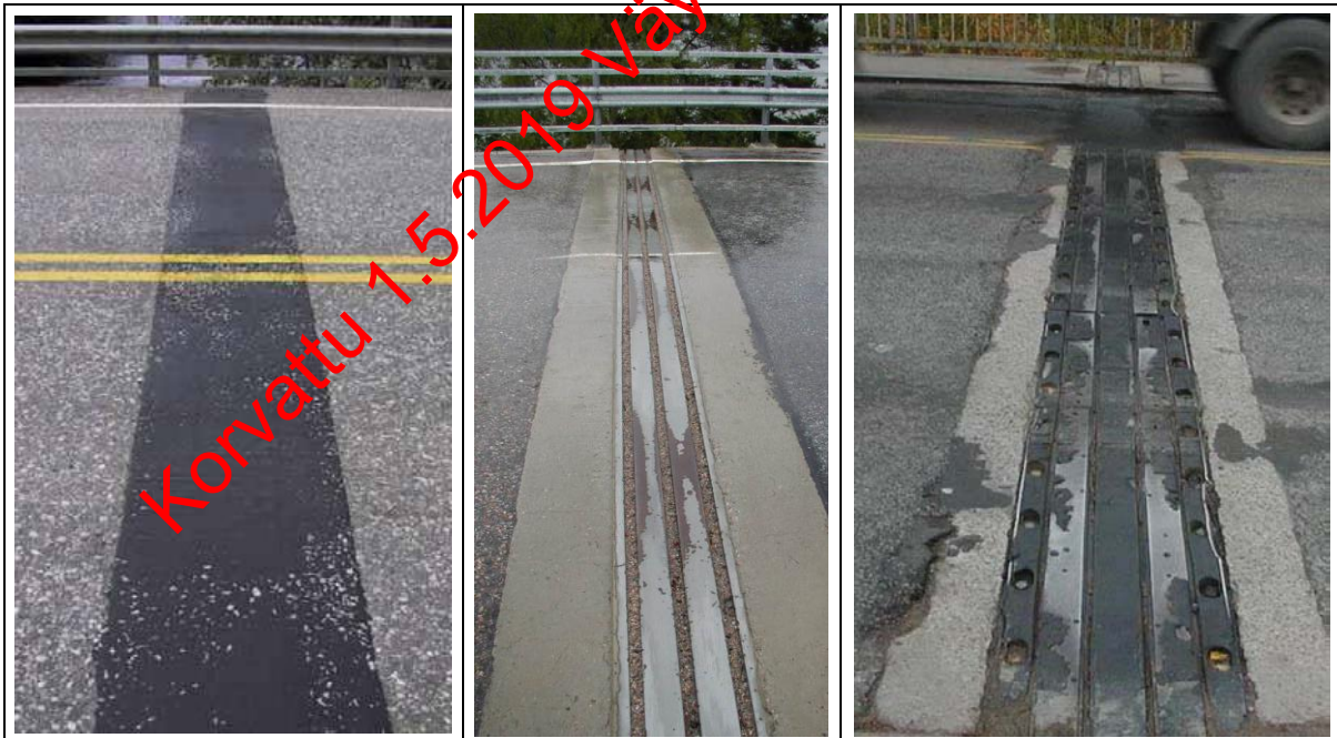
Kuva 12 Vasemmanpuoleisimmassa sillassa on massaliikuntasauma hyvässä kunnossa, joten vuositarkastusmerkintä tulee A-sarakkeeseen. Keskimmäisen sillan liikuntasaumalaite kaipaa puhdistusta, eli vuositarkastusmerkintä laitetaan B-sarakkeeseen. Oikeanpuoleisimman sillan liikuntasaumalaite on jo merkittävä korjausohjelmoitavaksi (D).
