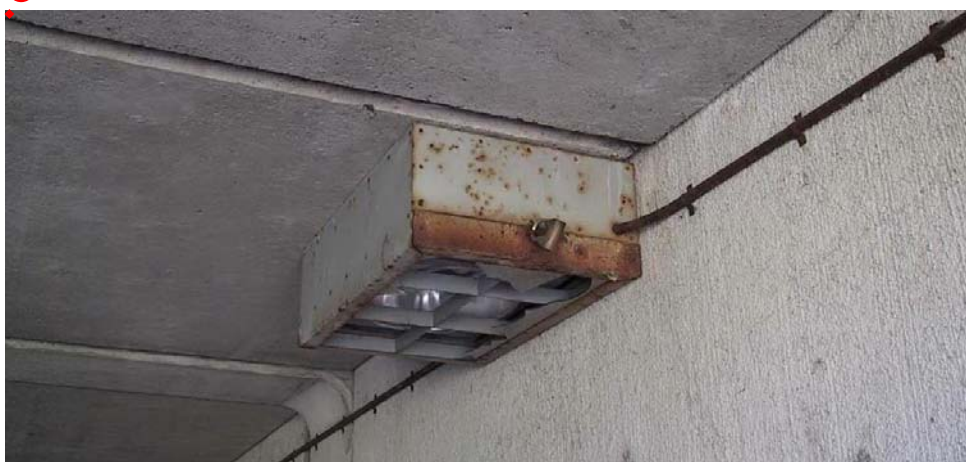
Kuva 17 Ylemmän alikulkukäytävän valaistuslaitteet ovat pääosin kunnossa (A), mutta alemman alikulkukäytävän valaistuslaitteiden kunto olisi syytä saat- taa tilaajan tietoon (D), sillä lamput ovat rikki ja valaisimet pahasti ruos- teessa.
