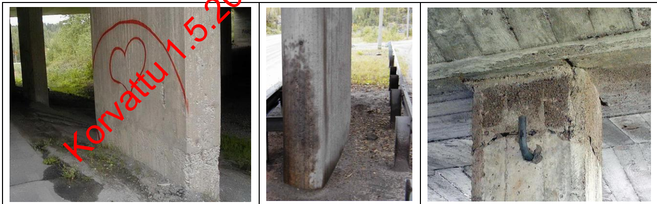
Kuva 2 Vuositarkastusmerkintä kuuluu B-sarakkeeseen kahden vasemmanpuoleisimman sillan välituen osalta. Vasemmanpuoleisimmassa tapauksessa irtomainen hiekka ja maa poistetaan välituen juurelta maanpinnan tasoon asti, keskimmaisessä pestään suolaroiskeet pois (vähintään 3 m korkeuteen saakka). Oikeanpuoleisessa kuvassa merkintä kuuluu sarakkeeseen D, sillä betoni on vaarallisesti lohkeillut välituen yläpäästä.
