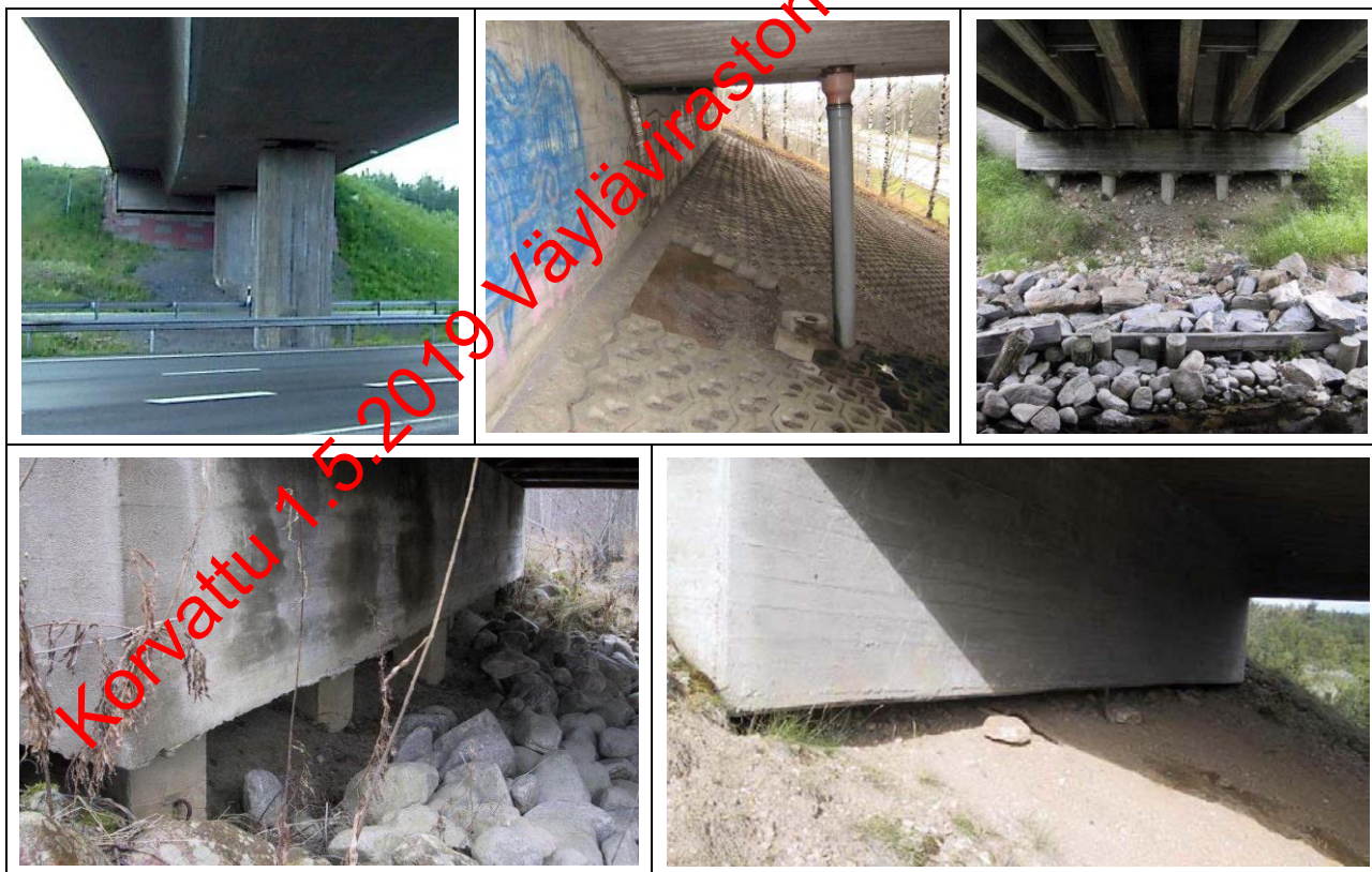
Kuva 21 Ylärivissä vasemmanpuoleisimman sillan tapauksessa etuluiska alkaa osoittaa jo heinittymisen merkkejä, joten B-sarake on oikea paikka vuositarkastusmerkinnälle, vaikka A-sarakekin saattaisi vielä yhden vuoden menetellä. Ylärivin keskimmaisessä sillassa etumuurin edessä on alle 2 m 2 :n kokoinen sidekivipurkautuma, joten vuositarkastusmerkintä kuuluu C-sarakkeeseen. Ylärivin oikeanpuoleisin silta on selkeä D-tapaus etuluiskan osalta, samoin kuin molemmat alarivin sillat.
