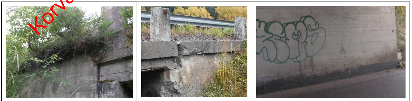
Kuva 1 Vuositarkastusmerkintä laitetaan B-sarakkeeseen kaikkien siltojen maatukien osalta, sillä maatuissa tai niiden päällä on kasvillisuutta ja maa-ainesta (vasen ja keskimmäinen silta) ja maatuet tulee niiltä osin puhdistaa, tai kyseessä on suolasumun rasittama risteys sillan maatuki (oikea silta), joka on selkeästi likainen ja puhdistamatta alaosaan. Huom. Keskimmäisen sillan maatuen rapautuminen on pitkän ajan tulosta ja täten jo ylläpidon tiedossa yleistarkastusten ansiosta, joten D-sarakemerkintä ei ole tarpeen, vaikka maatuki huonokuntoiselta näyttääkin.
