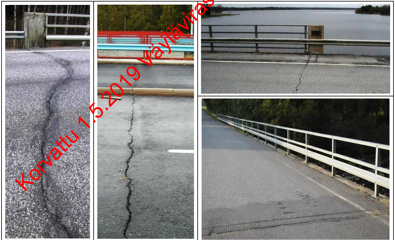
Kuva 9 Kahden vasemmanpuoleisimman ja ylimmän sillan tapauksessa vuositarkastusmerkintä tulee C-sarakkeeseen, sillä sillan päällysteeseen sillan ja penkereen rajamaille on ilmestynyt poikkisuuntainen halkeama, jonka korjaaminen kuuluu urakoitsijalle. Oikealla alhaalla olevassa sillassa on saumaa jouduttu korjailemaan useasti, ja voi olla asianmukaista ehdottaa tilaajalle päätysauman korjausta. Tällöin laitetaan vuositarkastusmerkintä sarakkeen C lisäksi myös sarakkeeseen D.
