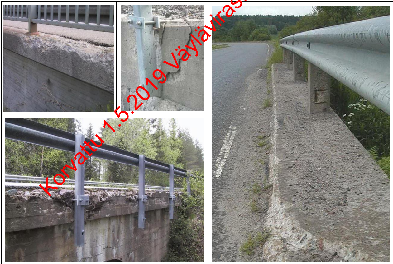
Kuva 6 Vasemmalla ylhäällä sillan reunapalkki on kunnossa hoidon alueurakoitsijan näkökulmasta (vaikka rapautumaa onkin) eli vuositarkastusmerkintä tulee A-sarakkeeseen. Oikeanpuoleisimman sillan reunapalkki kaipaa puhdistusta (merkintä B-sarakkeeseen). Ylhäällä keskellä ja alhaalla vasemmalla kaidteen kiinnitys on heikentynyt reunapalkin huonon kunnon vuoksi, joten vuositarkastusmerkintä laitetaan molemmissa tapauksissa D-sarakkeeseen.
