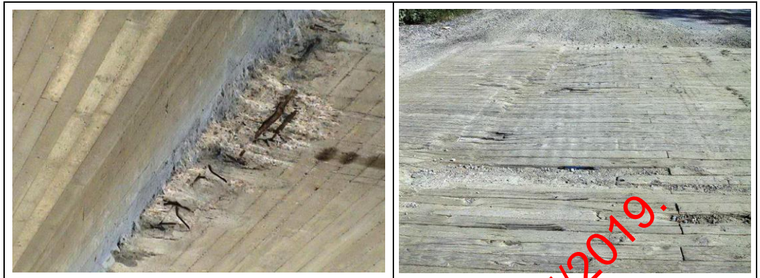
Kuva 4 Vuositarkastusmerkintä kuuluu D-sarakkeeseen vasemmanpuoleisen sillan osalta, sillä betonikannen alapinnassa on vakava törmäysvaurio. Oikeanpuoleisen sillan tapauksessa tulee vuositarkastuslomakkeeseen kaksi merkintää, B ja D: puukanalla oleva hiekka on poistettava (B), mutta sen lisäksi kansi on niin pahasti kulunut, että asiasta on syytä raportoida tilaajalle (D).
