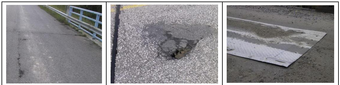
Kuva 5 Vuositarkastusmerkintä tulee C-sarakkeeseen kaikkien kolmen sillan osalta, sillä sillan päällysteessä olevien halkeamien, reikien, purkaumien ja liikennettä vaarantavien vaurioiden korjaukset kuuluvat hoitourakoitsijalle.
