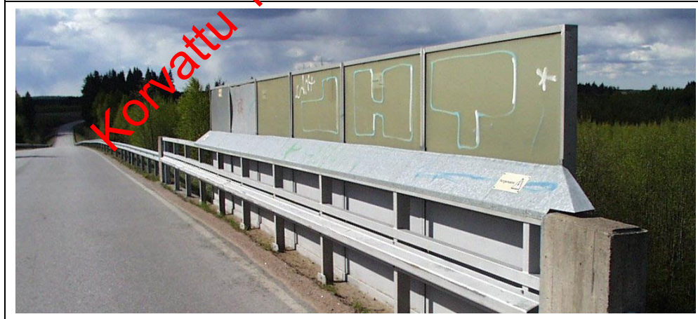
Kuva 16 Ylemmän sillan kosketussuoja näyttää hyväkuntoiselta (vuositarkastusmerkintä A-sarakkeeseen), mutta alemman sillan tapauksessa kosketussuojan toiseksi viimeinen lamelli näyttäisi olevan löysällä eli vuositarkastusmerkintä laitetaan C-sarakkeeseen.
