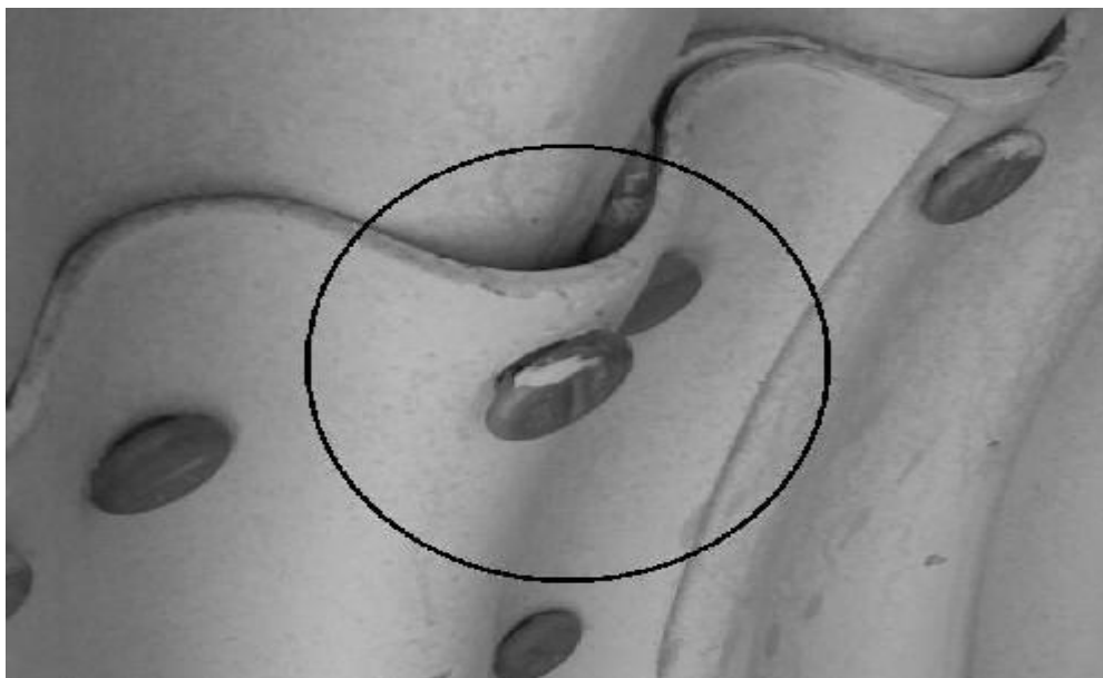
Kuva 11. Pultti, jolla ei ole leikkauslujuutta.
