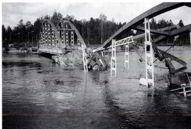
Kuva 9. Henkilövahinkoja aiheuttanut, purkamisvaiheessa sortunut silta.
