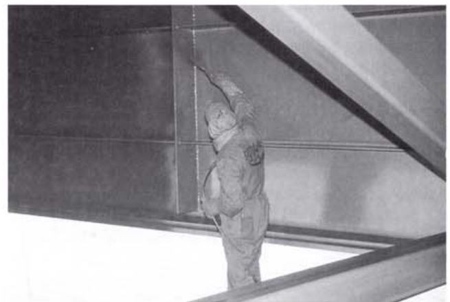
Kuva 22. Maalarin suojavaustus (A1P2).
