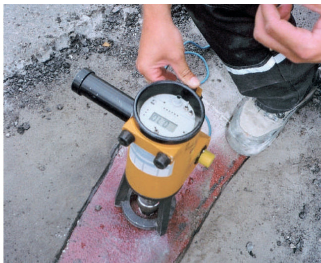
Kuva 62. Betonin tartuntalujuuden testaus tartuntavetokokeella.
