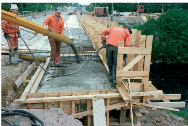
Kuva 2. Betonin valu on yleisin korjausmenetelmä
