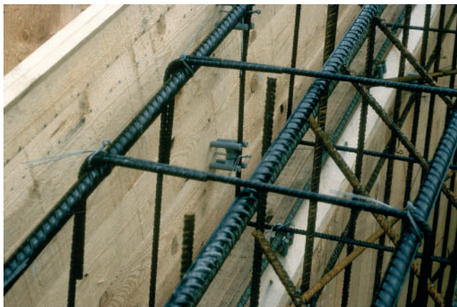
Kuva 45. Epoksipinnoitettu raudoite.
