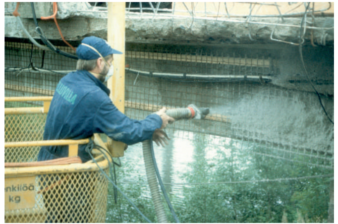
Kuva 54. Karbonatisoituneen betonin alkalointityön valmistelua.
