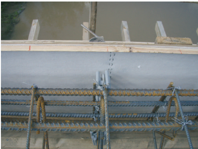
Kuva 49. Sillan reunan uusittu rauditus välikkeen ja muottikangas.
