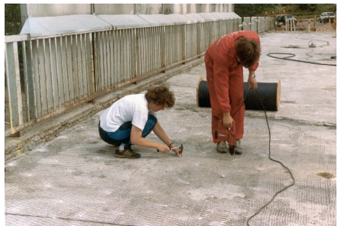
Kuva 55. Anodiverkon asennusta katodista suojauksusta varten.
