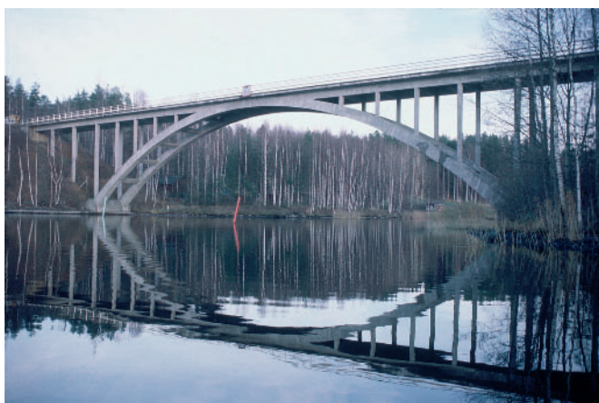
Kuva 1. Betonista voidaan tehdä monimuotoisia rakenteita
