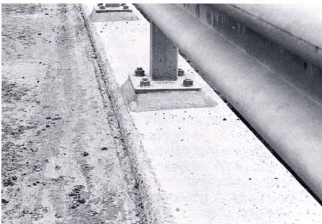
Kuva 12. Kaidepylvään kiinnitysvalu on tehty juotoslaastilla.
