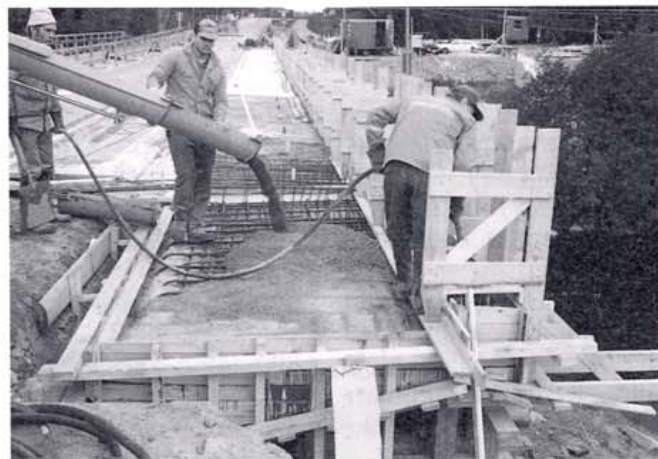
Kuva 14. Tehonotkistettua betonimassaa on helppo työstää.
