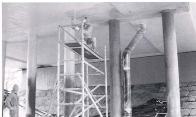
Kuva 2. Polymeeripinnoitteet levitetään yleensä ruiskutamalla.
