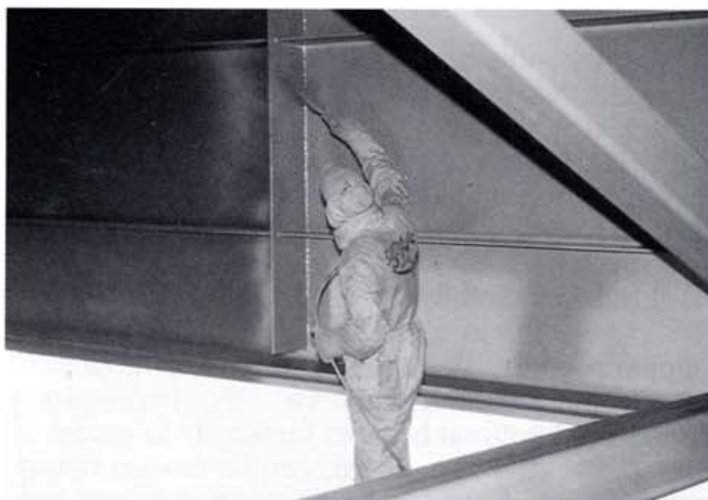
Kuva 17. Maali levitetään yleensä ruiskuttamalla.
