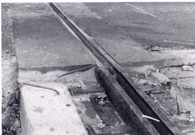
Kuva 9. Liikuntasaumalaitteen tukikaistan yläosa on valettu betonimuovista.
