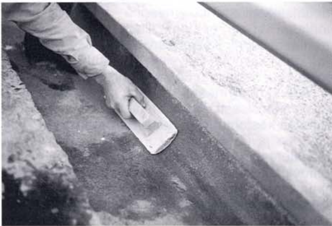
Kuva 11. Paikkauslaastista muotoiltu pulloholkka.
