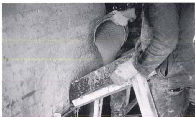
Kuva 3. Polymeereillä voidaan muunnella aineiden ominaisuuksia (kuvan massa ei erotu haitallisesti veden allakaan)
