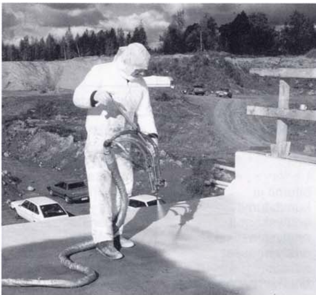
Kuva 19. Polyuretaanin ruiskutusta.
