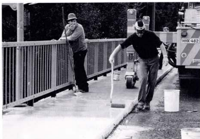
Kuva 20. Epoksipohjaisen ohutkerrospäällysteen levitystä.
