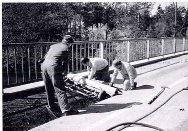
Kuva 18. Esisivelyaineen avulla kiinnitettävän vedeneristyskermin levitystä.
