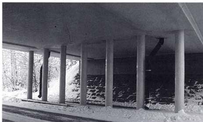
Kuva 26. Polyeteeniputkista tehtydt syöksytorvet.
