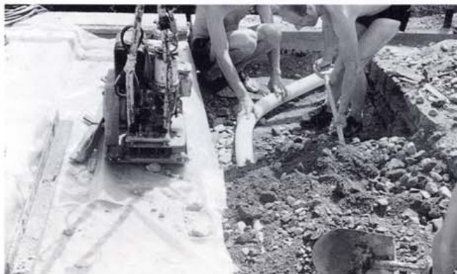
Kuva 27. Salaojaputken asennusta maatuen taustatäyttöön.
