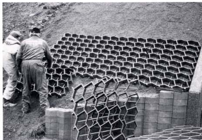
Kuva 28. Luiskakennojen asennusta.
