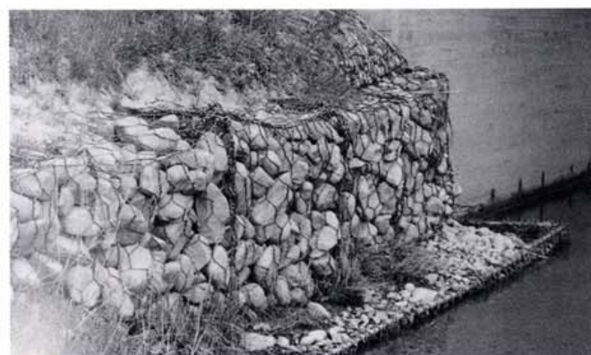
Kuva 29. Muovipinnoitettuja kivikoreja.
