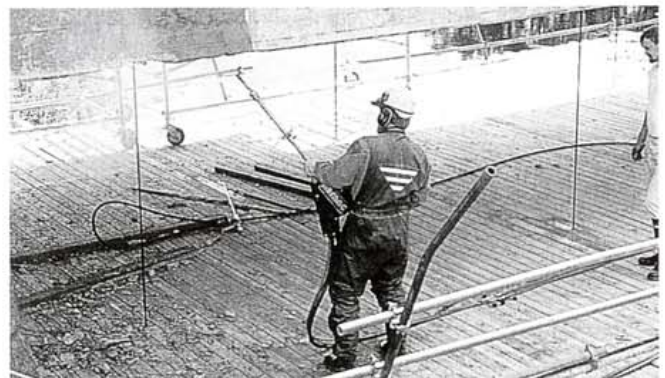
Kuva 21. Päällysrakenteen alapinnan vesipiikkausta.
