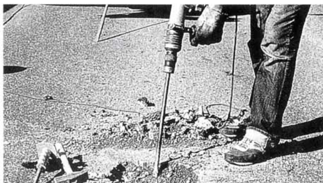
Kuva 16. Sähkökäyttöinen piikkausvasara.
