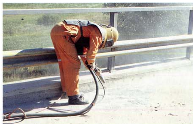
Kuva 3. Reunapalkin puhdistusta hiekkapuhalluksella.
