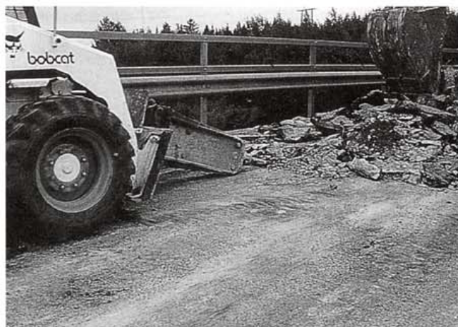
Kuva 15. Piikkausvasara työkoneeseen kiinnitettynä.
