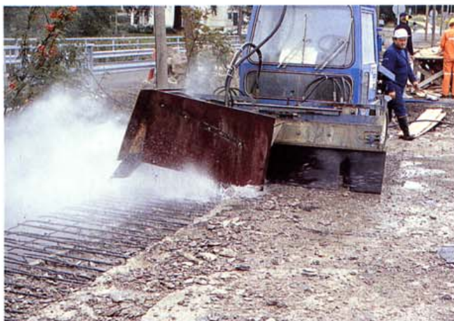
Kuva 1. Sillan reunaa puretaan vesipiikkaamalla.
