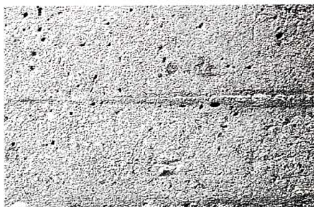
Kuva 45. Normaalisti suihkupuhdistettu betonipinta.
