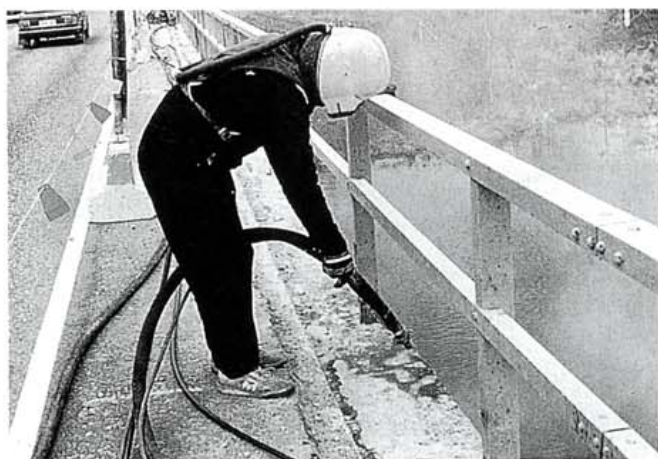
Kuva 35. Betonipinnan suihkupuhdistusta hiekkapuhalluksella.
