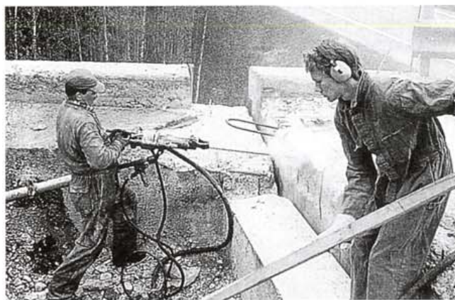
Kuva 23. Raudoitustankojen ankkurointireikien porausta iskuporakoneella (polvisyöttö).
