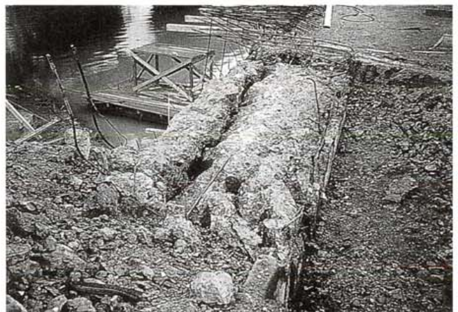
Kuva 30. Paisunta-aineella murrettu siipimuuri.
