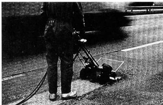
Kuva 37. Betonipinnan liekkiharjausta.
