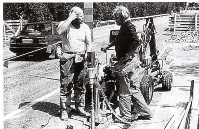
Kuva 24. Tippuputkien reikien porausta lieriöporalla.
