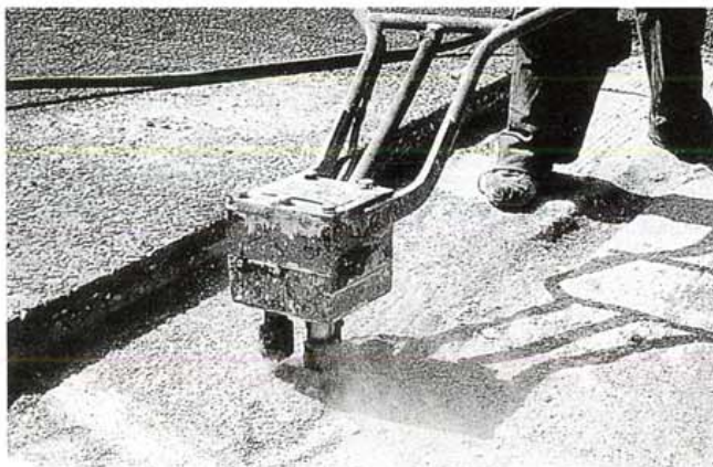
Kuva 33. Pieniin kohteisiin sopiva hakkuri.
