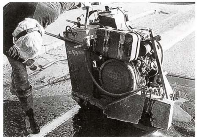
Kuva 27. Päällysteen paikkauskohdan rajausta holvisahalla.
