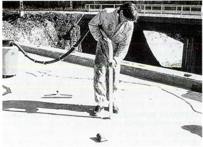
Kuva 40. Sillan kannen imurointia.
