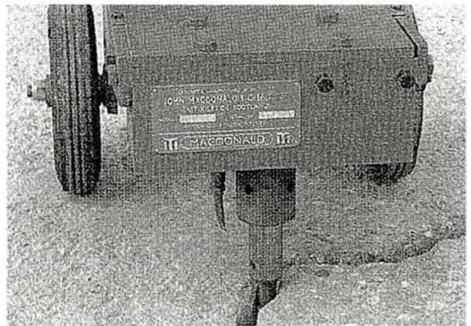
Kuva 31. Halkeaman avausta kovametalliterällä.
