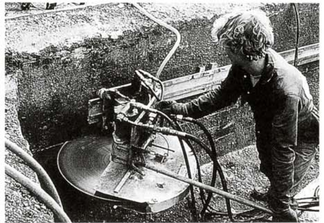
Kuva 26. Otsamuurin yläosa leikataan pois seinäsahalla.
