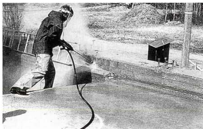
Kuva 39. Sillan reunaosien pesua suurpainepesurilla.
