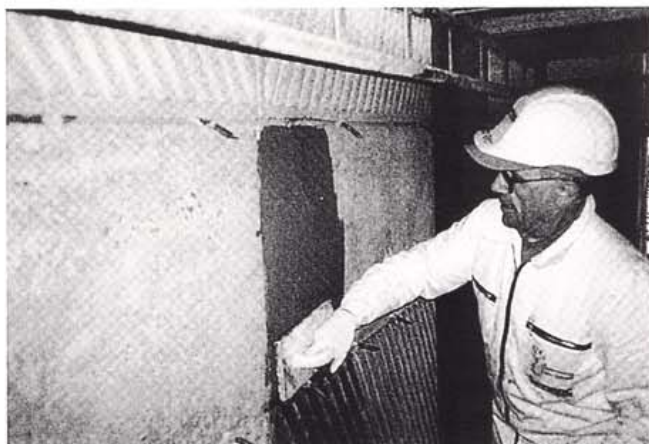
Kuva 2. Paikkaus valumattomalla laastilla.
