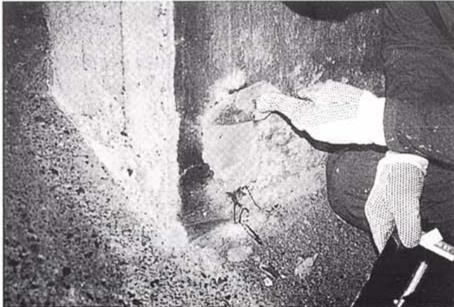
Kuva 15. Pienen kolon paikkaus on tehty paikkausmassalla.
