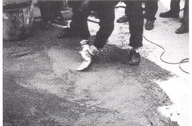
Kuva 16. Vedeneristyksen alusta on paikattu kuumuutta kestäväällä juotosmassalla.
