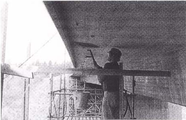
Kuva 23. Paikkausta ejektorilla.
