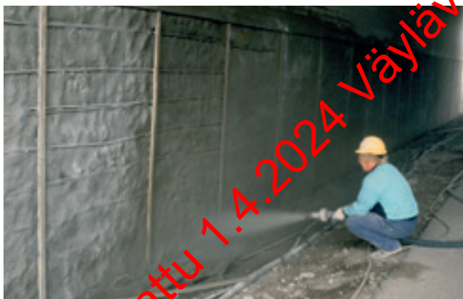
Kuva 2. Betonin ruiskutusta.
