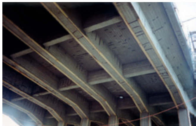
Kuva 30. Palkkien ja pilareiden muodon säilyminen on varmistettu muottien avulla.
