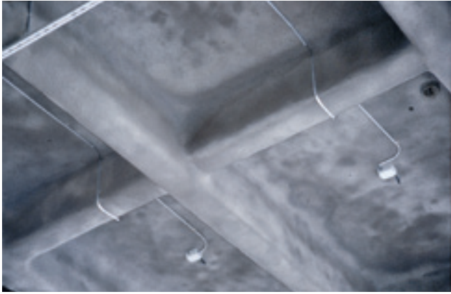
Kuva 8. Katodisen suojauksen anodiverkko on suojattu ruiskubetonilla (Emäkosken silta, Nokia).
