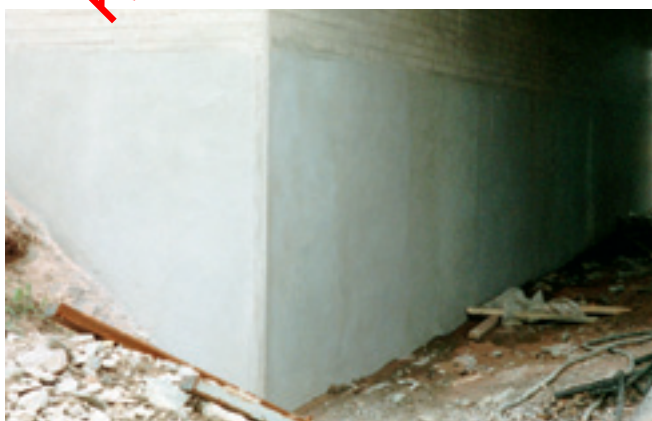
Kuva 3. Valmis ruiskubetonipinta.
