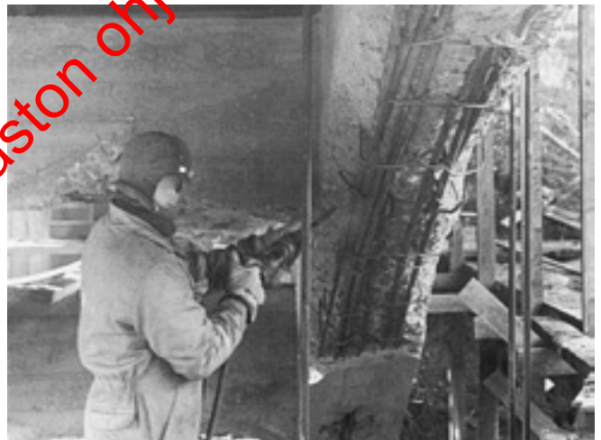
Kuva 26. Ruiskubetonoitavan kaaren piikkausta.
