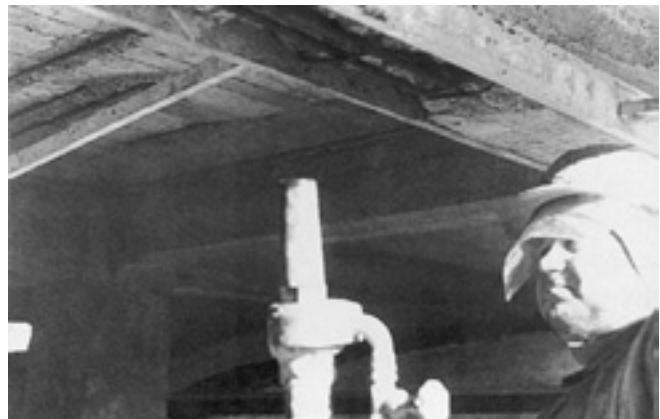
Kuva 13. Betonipeitteen riittävyys on varmistettu muotin avulla.
