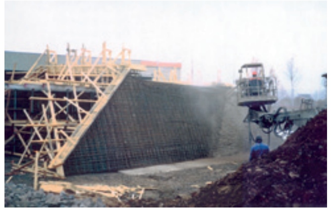
Kuva 9. Ruiskubetoniin perustuva työppösilta.
