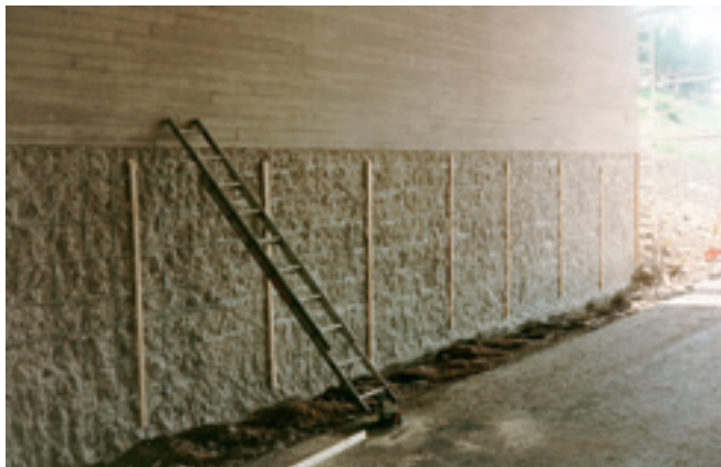
Kuva 1. Ruiskubetonointialusta.
