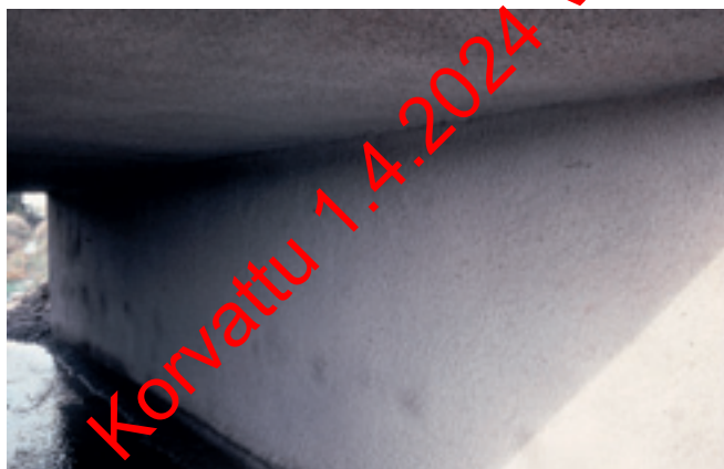
Kuva 17. Hyvä ruiskubetonipinta.
