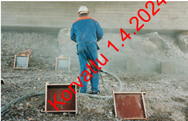
Kuva 34a. Koelaattojen ruiskutusta
