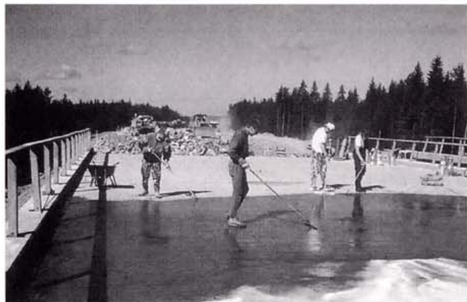
Kuva 2. Eristysalustan tiivistystä.
