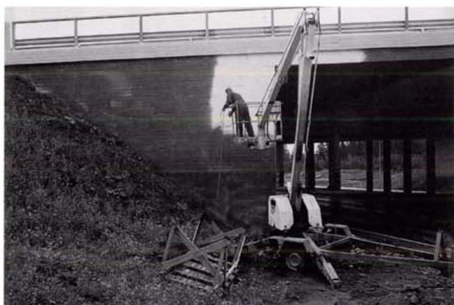
Kuva 3. Pinnoitusta ruiskuttamalla.
