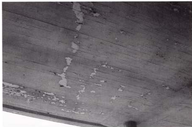
Kuva 8. Pinnoitekerrokset ovat irronneet toisistaan työvirheen vuoksi.
