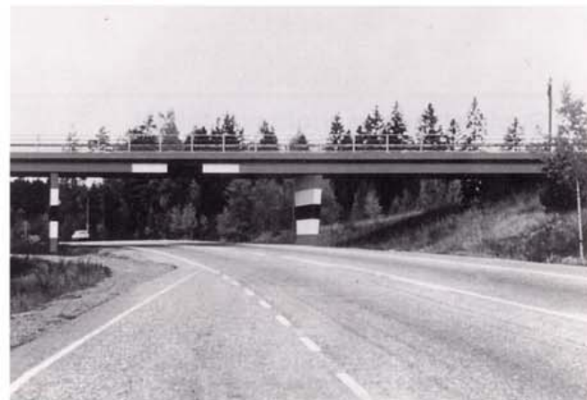
Kuva 5. Värityskokeilussa mukana ollut (Nummenkylän risteyssilta, Vihti).
