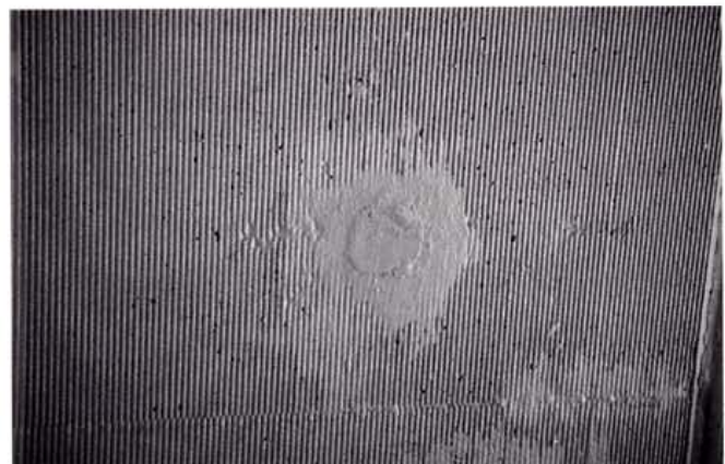
Kuva 32. Rumasti erottuva tartuntavetokokeen paikkaus.
