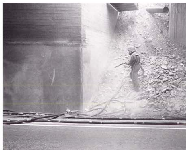
Kuva 27. Suihkupuhdistusta hiekkapuhallusmenetelmällä.
