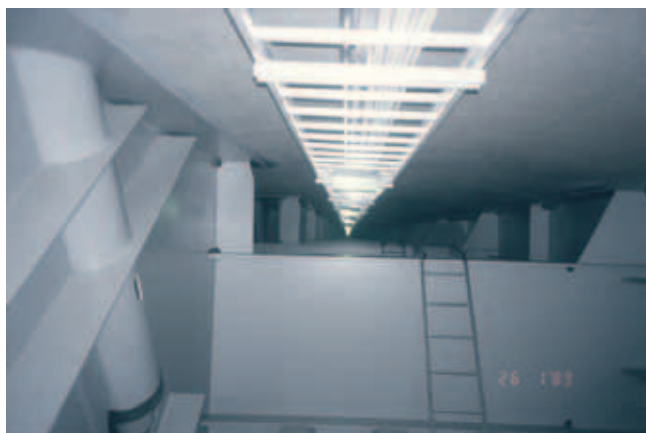
Kuva 3. Kaapelihyllyt valmistetaan alumiinista.
