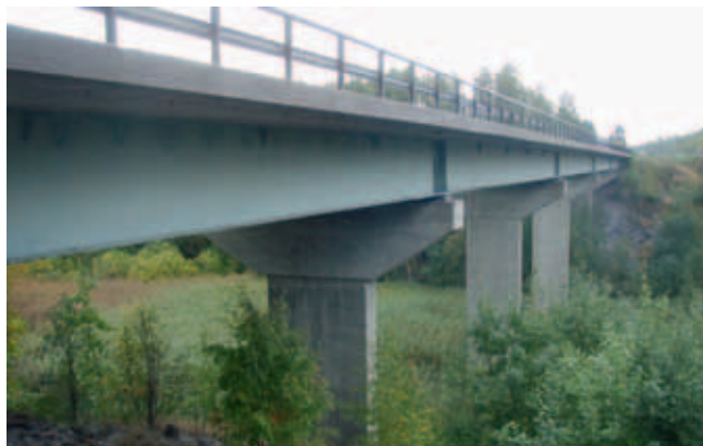
Kuva 1. Teräksinen palkkisilta on yleisin terässäilta.
