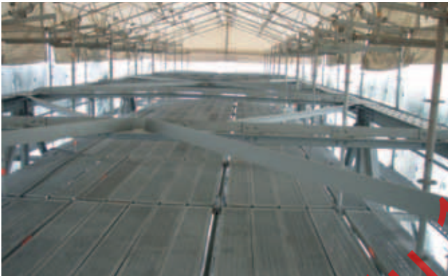
Kuva 25. Hyvä esimerkki teräsristikosillan huputtamisesta ja telineistä.
