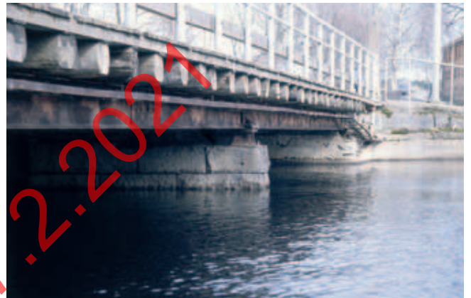
Kuva 10. Taipuma teräspalkissa.
