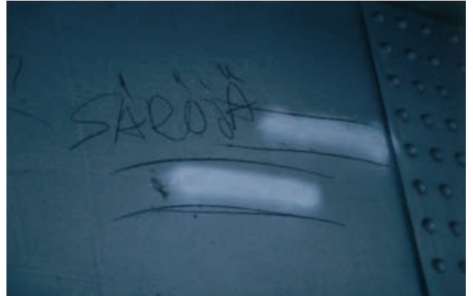
Kuva 9. Halkeamia teräspalkin uumassa.
