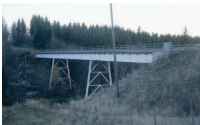
Kuva 8. Puukantinen teräspalkkisilta ja teräsraken-teiset välituet (Saikkalan silta vuodelta 1934).
