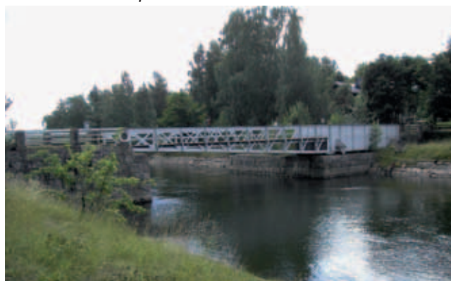
Kuva 7. Vuonna 1897 valmistunut Strömman kanavan ristikkorakenteinen kääntösilta.
