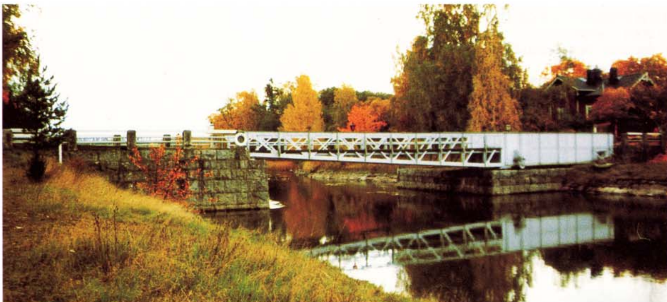
Kuva 4. Strömman kanavan vanha silta on suojattu maalaamalla vuodesta 1897 lähtien.
