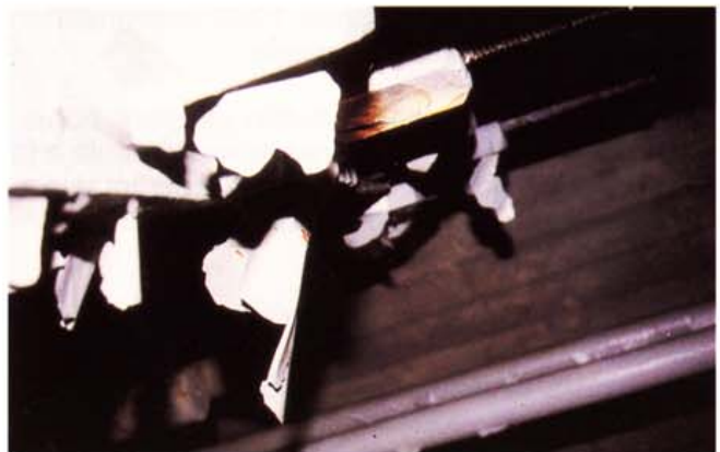
Kuva 8. Hilseilevä maalipinta.
