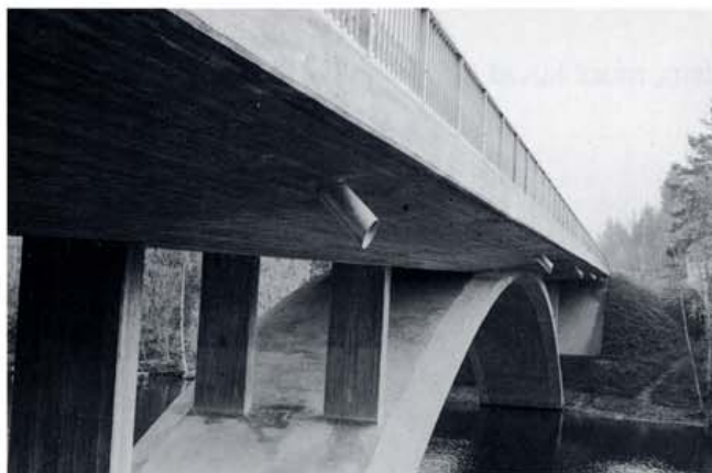
Kuva 2. Sillan päällysrakenteen syöksytorvet ja tippuputket.
