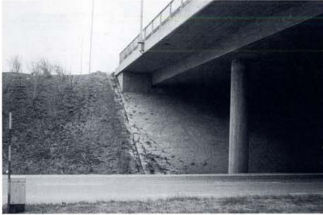
Kuva 36. Pintavesikouruksi muotoiltu etuluiskan reuna.
