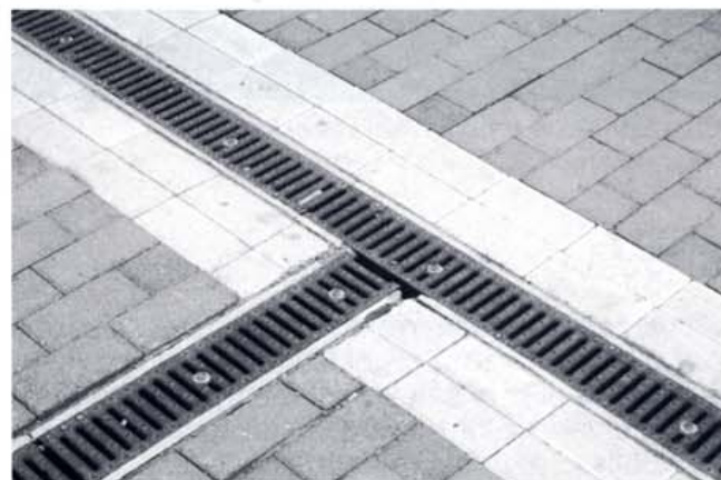
Kuva 27. Ritiläkannella varustettu kouru.
