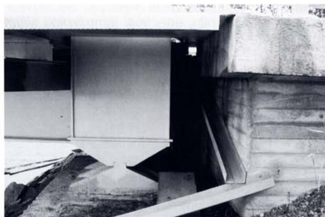
Kuva 26. Teräksinen pintavesikouru.
