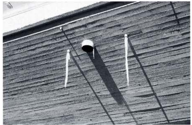
Kuva 39. Sillan reunoissa ja kaidepylväiden juurissa olevat tippuputket ja syöksytorvet avautuvat päällysrakenteen alapintaan.
