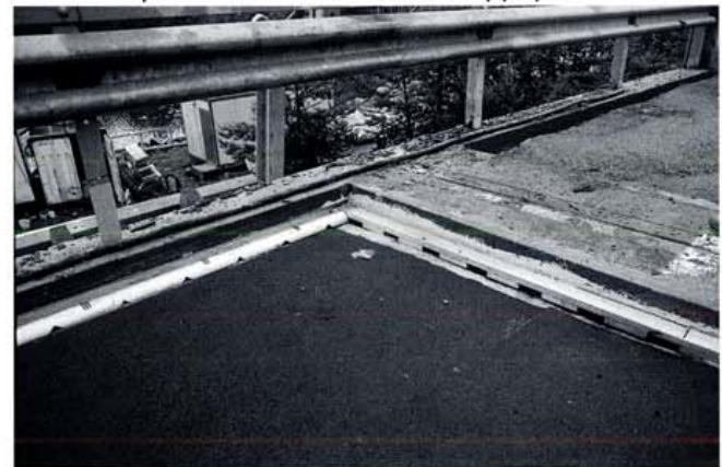
Kuva 42. Salaojat tippuputkilinjan päällä sillan reunassa ja liikuntasauman vieressä sillan poikkisuunnassa
