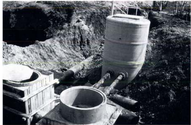
Kuva 46. Alikulkukäytävän pumppaamo rakenteilla.
