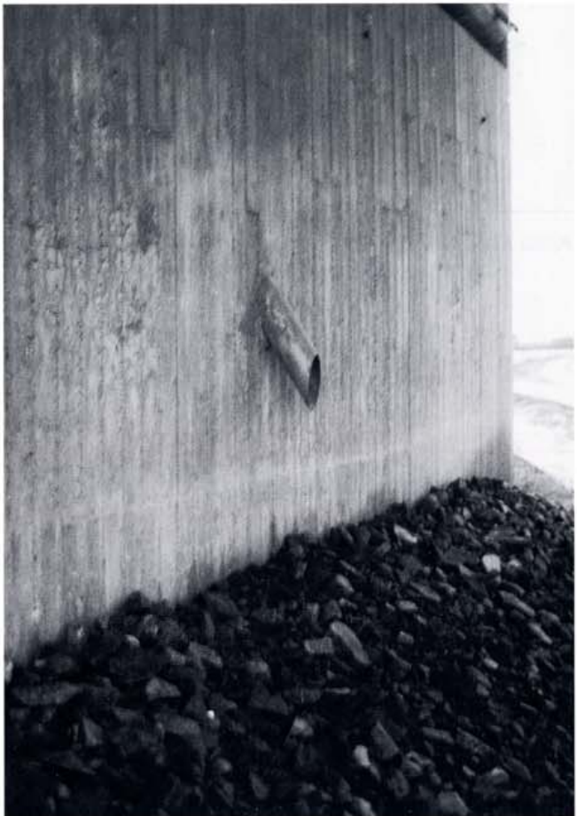
Kuva 23. Vedenpoistoputki etumuurin läpi.
