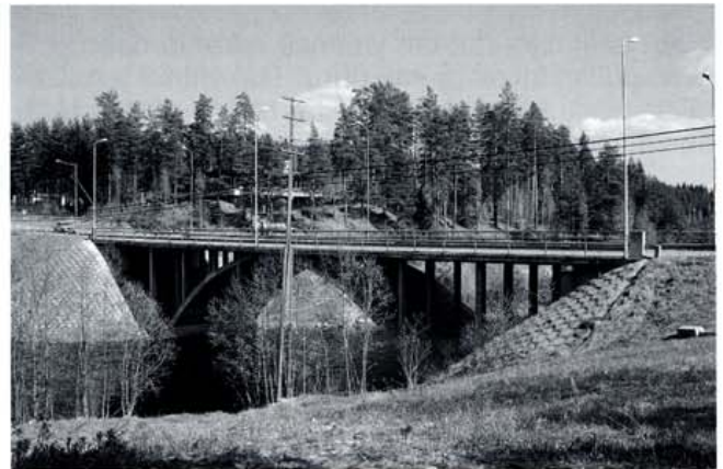
Kuva 17. Koverassa taitteessa oleva silta on yleensä hankala kuivatuksen kannalta.
