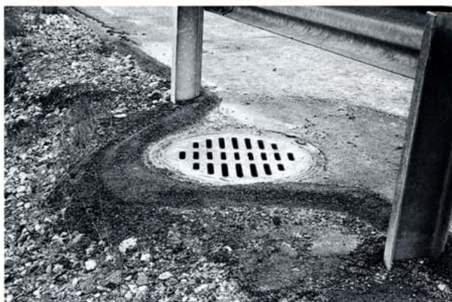
Kuva 32. Asfaltista tehty reunas, jolla vedet ohjataan pintavesikaivoon.
