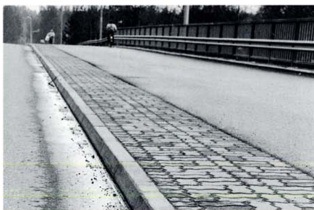
Kuva 33. Reunatuista tehty reunas korotetun jalkakäytävän reunassa.
