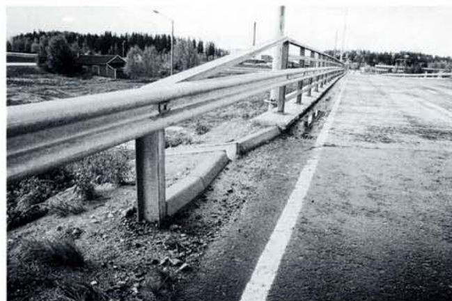
Kuva 34. Reunas ja suppilo pintavesikourun yläpäässä.
