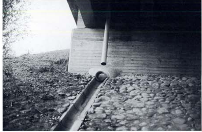
Kuva 38. Kaivonrenkaasta tehty loiskekuppi
