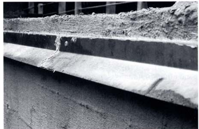
Kuva 31. Tippulista korkean reunapalkin yläosassa.
