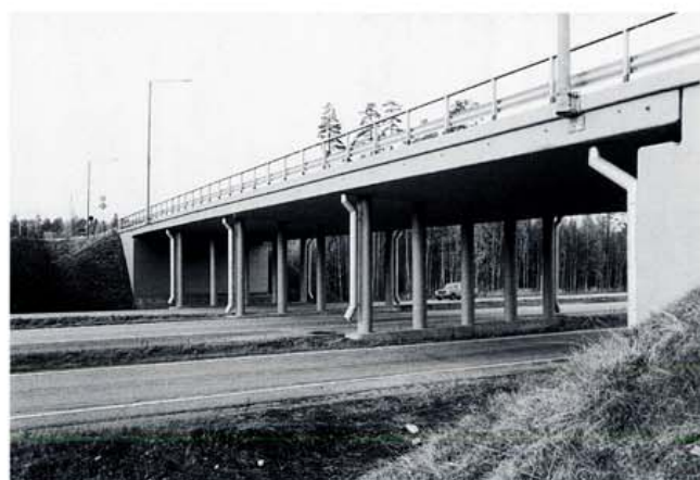
Kuva 21. Oikein jatkettut syöksytorvet.
