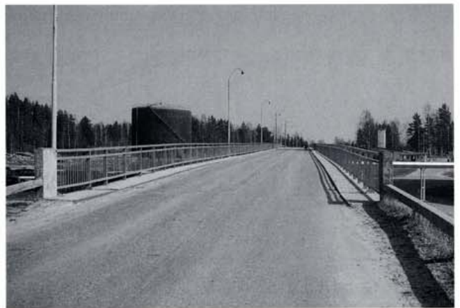
Kuva 18. Suoralla tieosalla ja loivassa pituuskaltevuudessa oleva silta on hyvä kuivatuksen kannalta.
