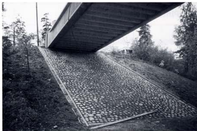
Kuva 25. Betoniset pintavesikourut etuluiskan reunois- sa.
