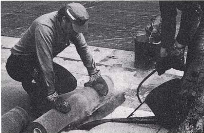
Kuva 1. Kermieristysten tekoa liimaamalla.
