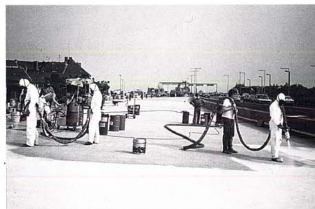
Kuva 3. Massaeristysten tekoa ruiskuttamalla.
