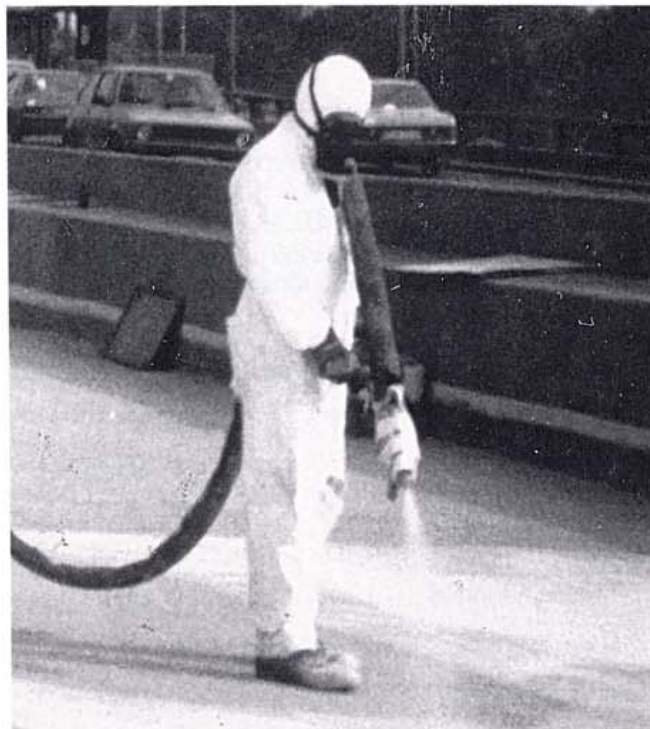
Kuva 16. Massaeristuksen ruiskuttajan suojavaatetus.
