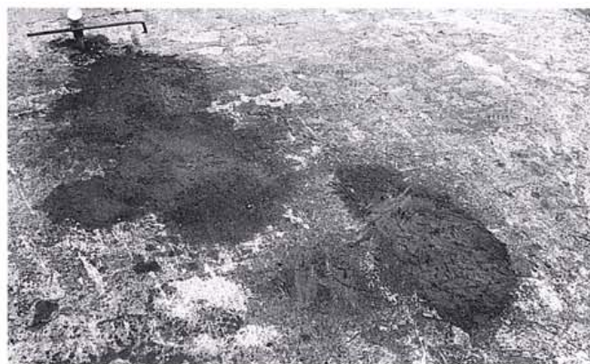
Kuva 8. Eristysalustaan ei saa jäädä työkoneista valunutta öljyä.
