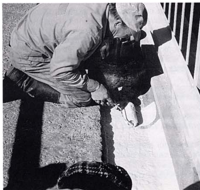
Kuva 26. Eristysmassan levitystä telalla.
