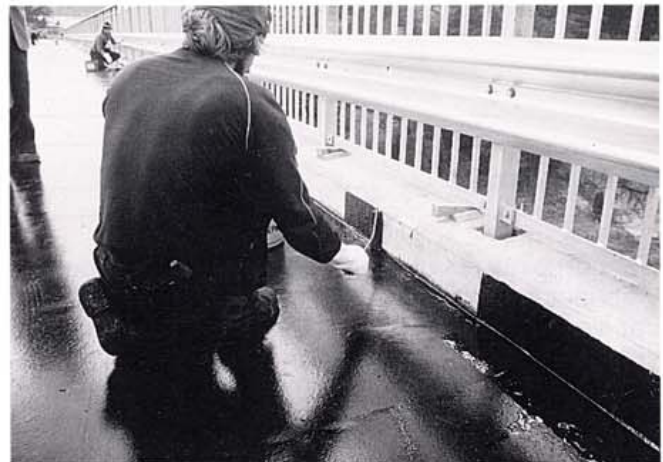
Kuva 31. Mastiksieristuksen tiivistystä sillan reunassa.
