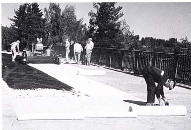
Kuva 24. Paineentasausverkon levitystä.
