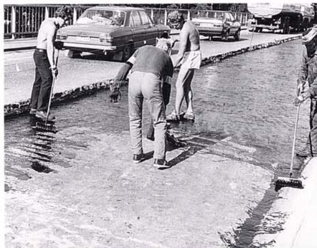
Kuva 19. Tartunta-ainetta levitetään harjaamalla.
