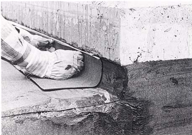
Kuva 30. Sillan reunassa käytetään kapeampaa kermikaistaa.
