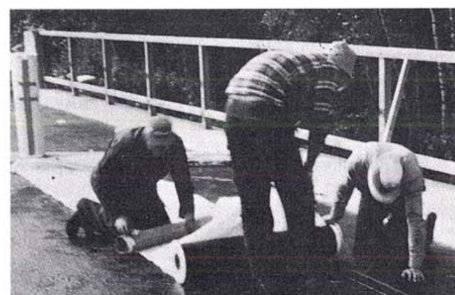
Kuva 23. Itseliimautuvan kermien asennusta.
