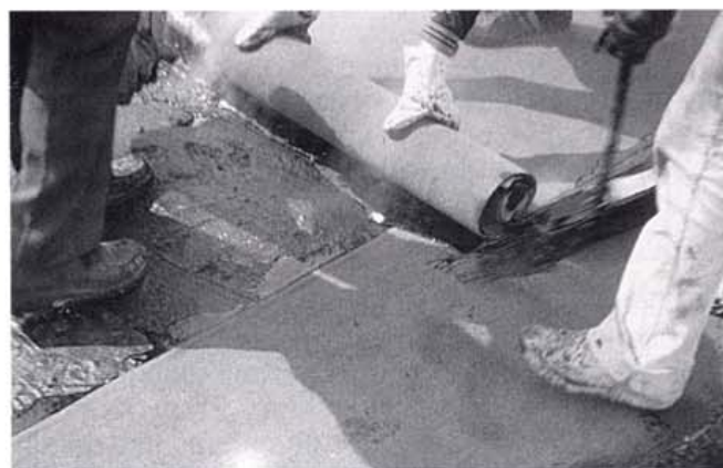
Kuva 20. Eristyskermin asennusta liimaamalla.
