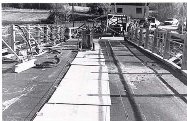
Kuva 33. Vedeneristys suojataan tarvittaessa työn aikana.
