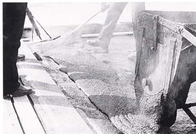
Kuva 25. Eristysmastiksin levitystä.
