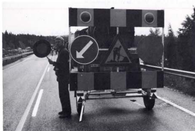
Kuva 18. Korjattava kaista suljetaan liikenteeltä
