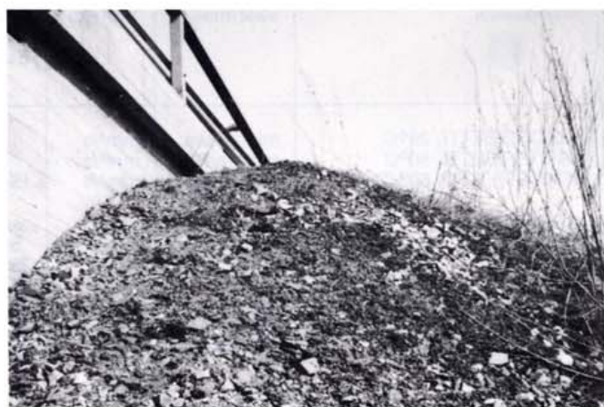
Kuva 19. Asfalttijätteillä sotkettu keila
