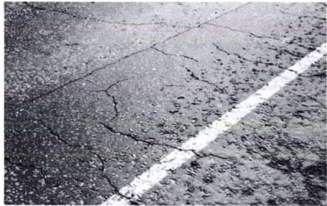
Kuva 8. Kutistumishalkeamia valuasfalttipäällysteessä
