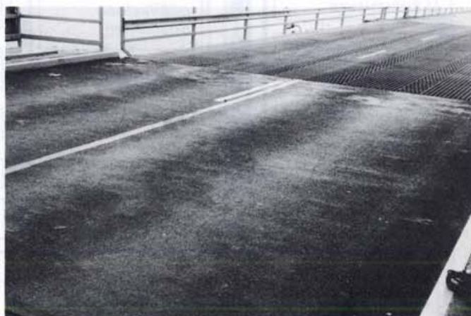
Kuva 6. Ohutkerrospäällyste
