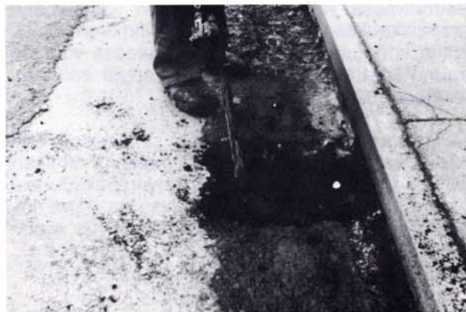
Kuva 14. Päällyste on syytä avata ainakin sillan reunassa
