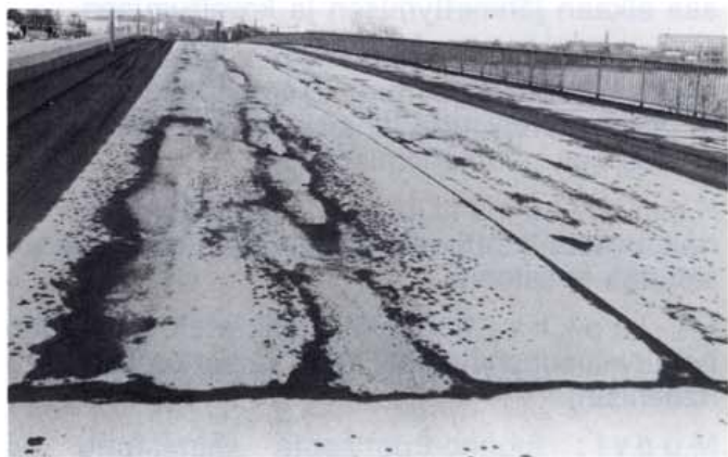
Kuva 10. Kulumisuria asfalttibetonipäällysteessä
