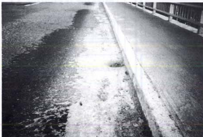
Kuva 4. Valuasfalttipäällyste ajoradalla ja asfalttibetonipäällyste jalkakäytävällä
