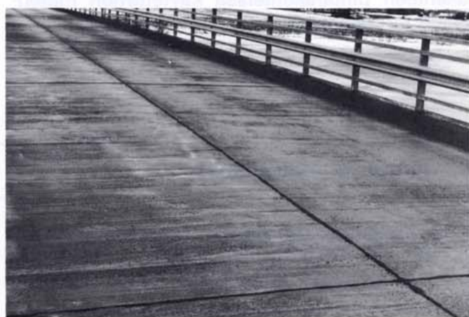
Kuva 5. Sillan betoninen ajotielaatta
