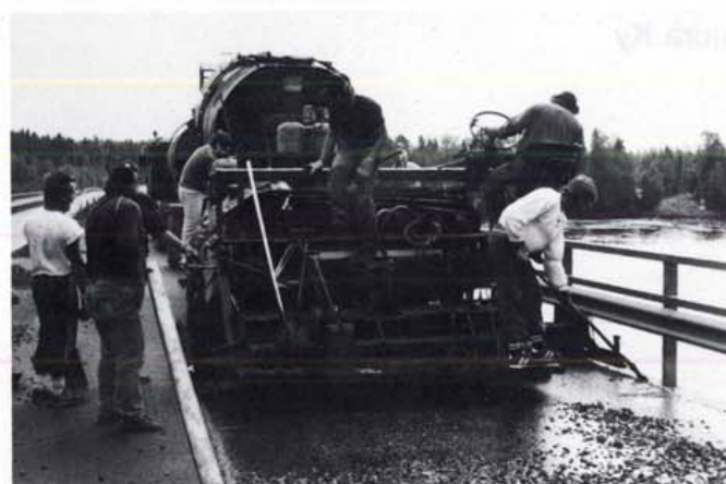
Kuva 3. Päällysteen uusiminen.
