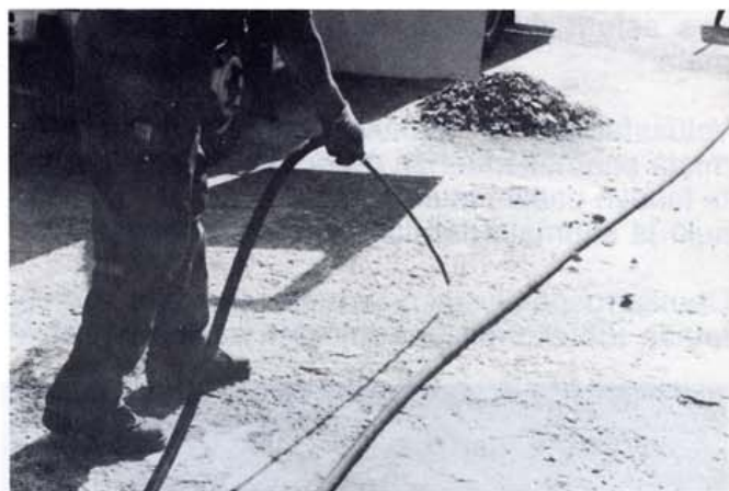
Kuva 27. Päällystysalusta puhdistetaan lopuksi mieluimmin paineilmalla
