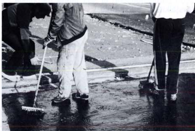
Kuva 29. Tartunta-aine levitetään harjaamalla
