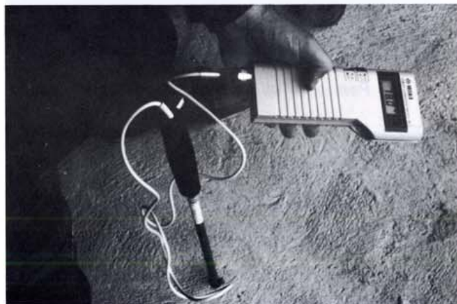
Kuva 22. Ohutkerrospäällysteen alustan kosteusmittaus (RH)
