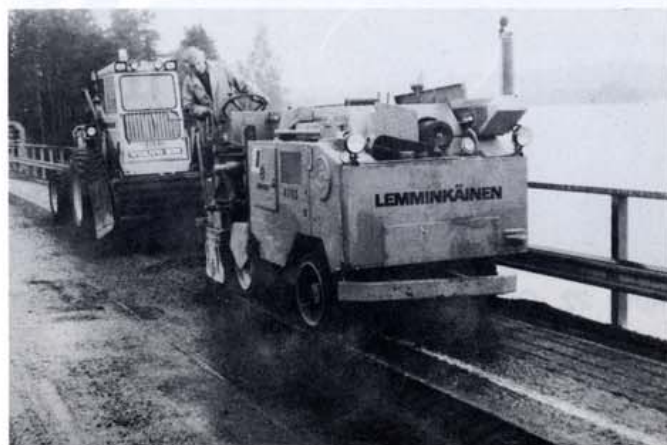
Kuva 24. Päällystealusta muotoillaan jyrsimällä oikeaan kaltevuuteen
