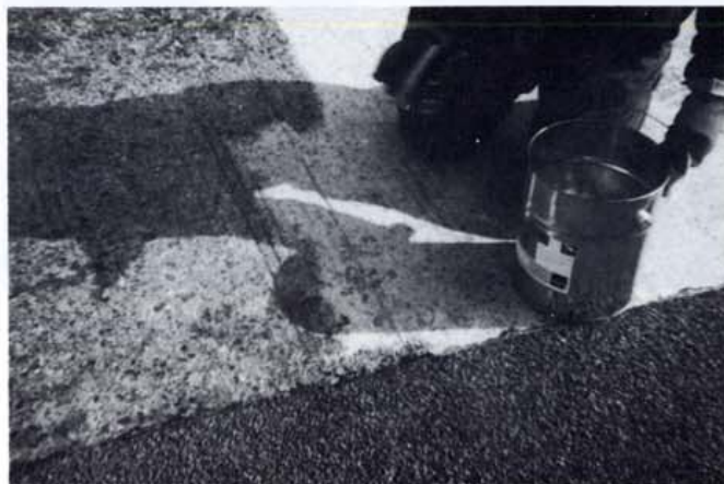
Kuva 31. Esisive-lyaine levitetään yleensä siveltimellä
