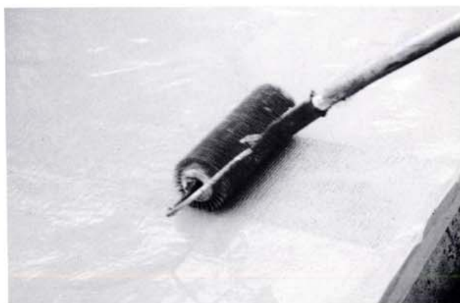
Kuva 34. Ohutkerrospäällyste viimeistellään piikkitelalla, jotta massan sisään ei jää ilmapuolia
