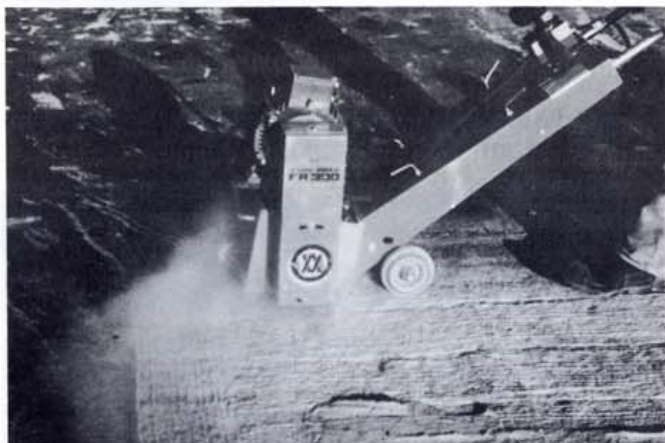
Kuva 26. Korjauskohteen reuna viimeistellään kevyellä jyrsimellä
