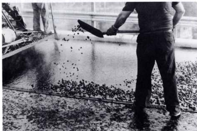
Kuva 33. Valuasfalttipäällysteen tekoa
