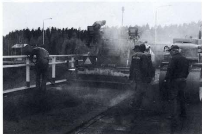
Kuva 32. Asfalttibetonipäällysteen tekoa
