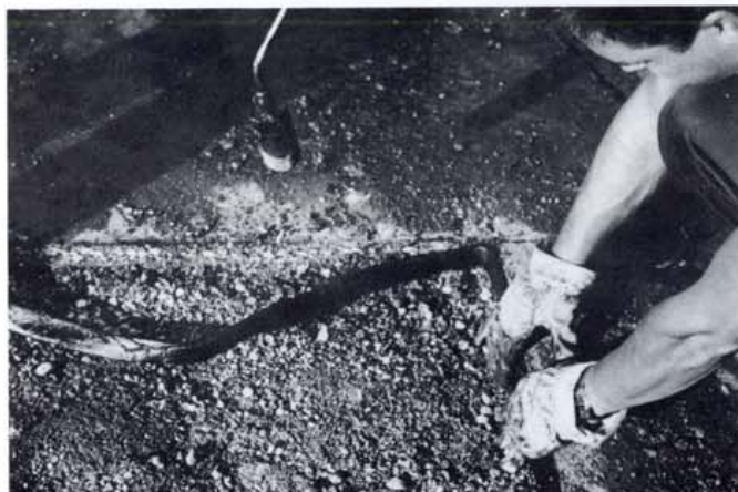
Kuva 30. Kumibitumisen saumausnauhan kiinnitystä
