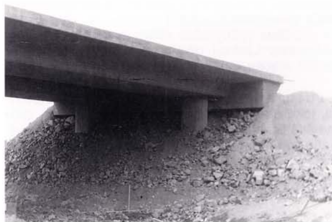
Kuva 8. Keila-aihi ilman pintakerrosta eli verhousarinaa
