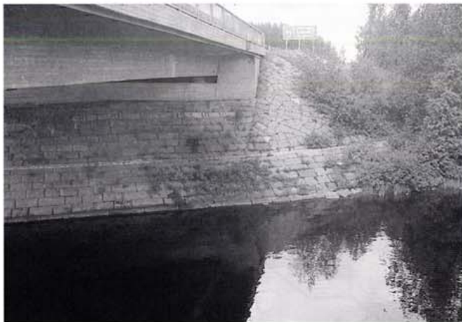
Kuva 21. Välitasanne korkeassa keilassa ja luiskassa
