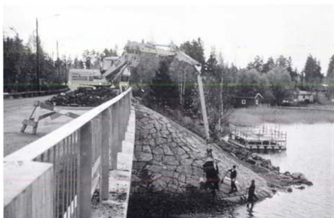
Kuva 12. Keilan kivilaattaverhousta korjataan
