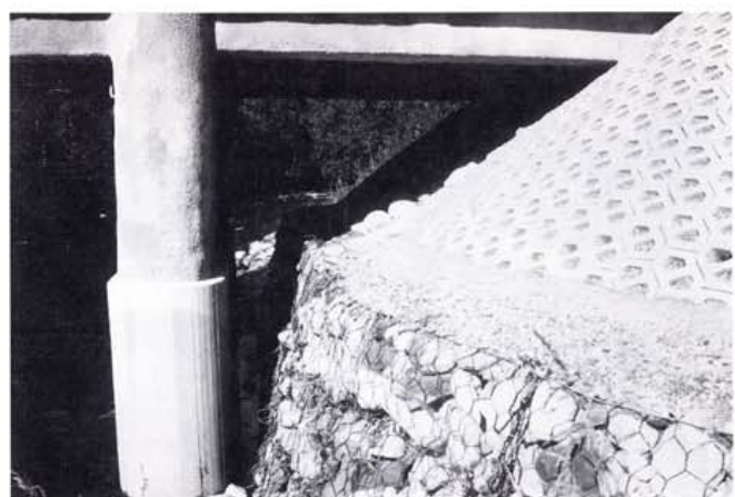
Kuva 16. Välitukeen kohdistunut maanpaine on eliminoitu keilan juureen tehdyllä kivikoritukimuurilla
