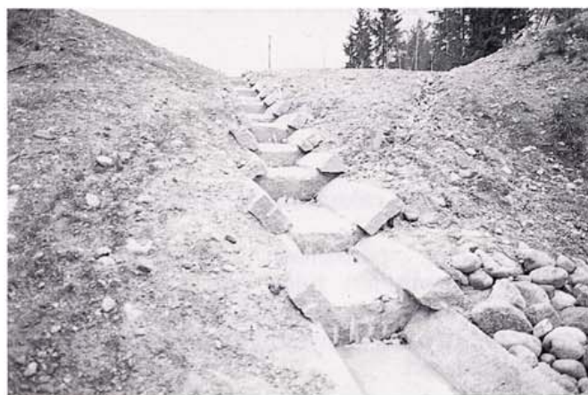
Kuva 7. Kiviporras sivuojan eroosiosuojauksena
