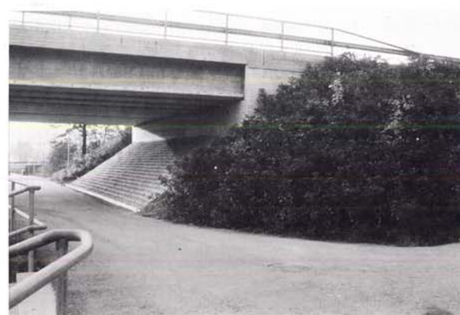
Keila- ja luiskarakenteet valmiina
