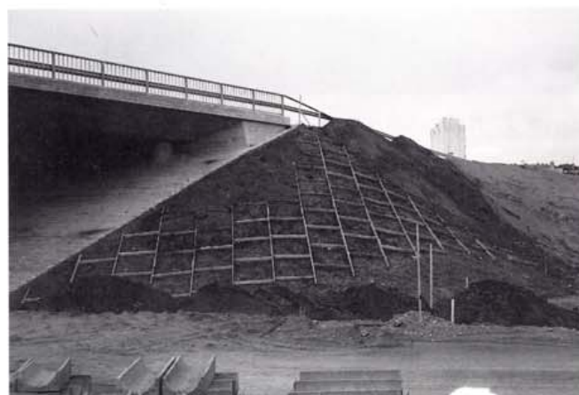
Verhous rakenteilla
