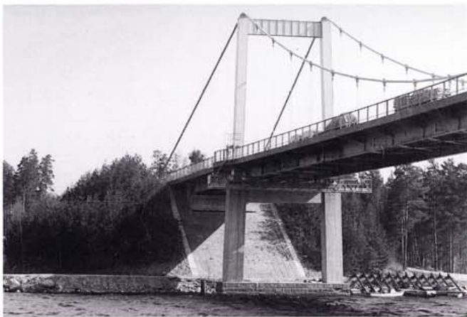
Kuva 14. Korkeahko betonilaattaverhouksen etuliskassa
