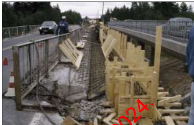
Kuva 4. Suojakaide työskentelyalueen ja ajoradan välissä.
