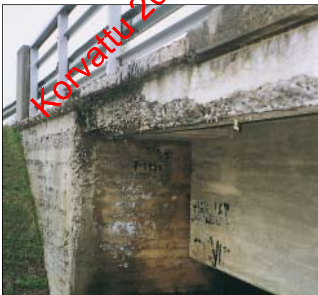
Kuva 2. Rapautuminen on edennyt niin pitkälle, että reunapalkki on uusittava.
