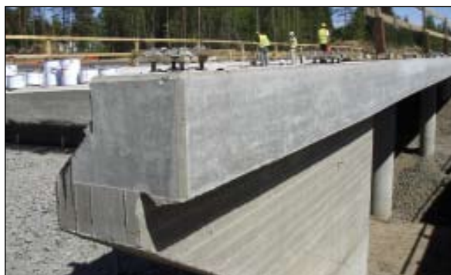
Kuva 12. Muottikangasta vasten valettu pinta.
