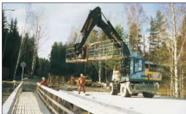
Kuva 11. Muottien asentamiseen ja purkamiseen sopiva nostokori.
