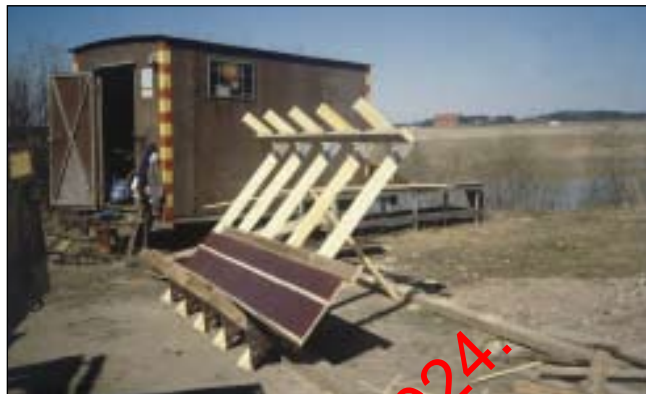
Kuva 9. Kaiteen varaan asennettava muottielementti.
