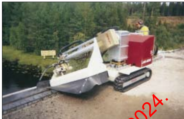
Kuva 6. Reunapalkkia puretaan vesipiikkausella, mikä on suositeltavin purkamismenetelmä.
