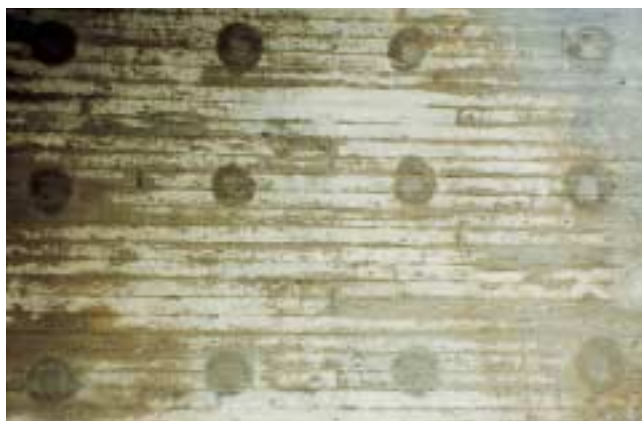
Kuva 3. Häiritsevästi erottuvia paikkauksia.
