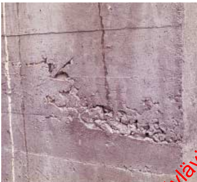
Kuva 1. Valumattomalla paikkauslaastilla tai -massalla ilman muotteja korjattava valuvika.
