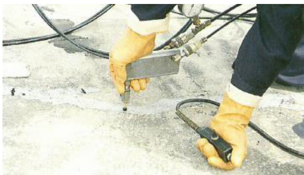
Kuva 4. Injektointilaitte, jossa komponentit sekoittuvat vasta suuttimessa.
