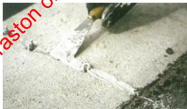
Kuva 6. Sulkuaine levitetään lastalla.
