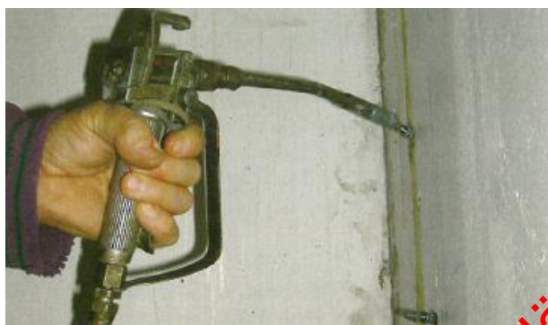
Kuva 7. Mansetilla kiinnitettävää injektointitulppaa.
