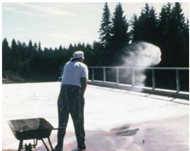
Kuva 17. Sirotteen levitystä tuoreen epoksin pinnalle.
