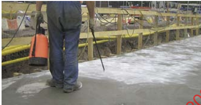
Kuva 10. Jälkihoitoaine levitetään ruiskulla.
