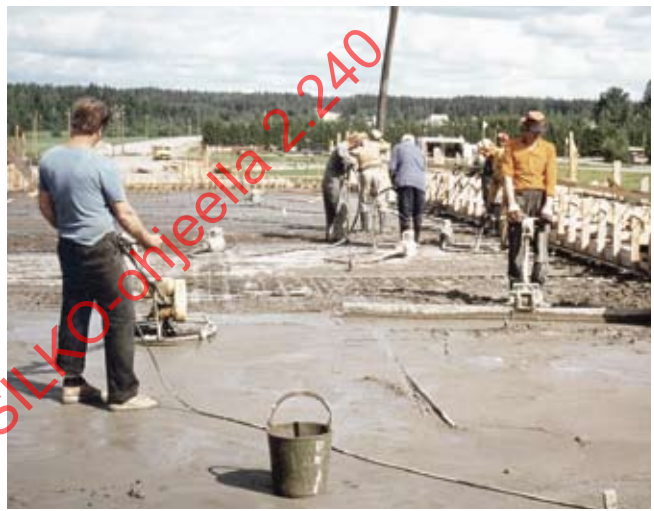
Kuva 9. Pinta hierretään heti, kun muotoiluvalu kantaa koneen.
