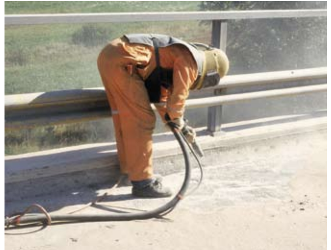
Kuva 12. Eristysalustan suihkupuhdistusta hiekkapuhalluksella.
