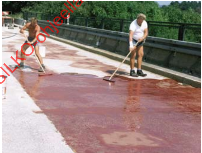
Kuva 16. Epoksin levitystä.
