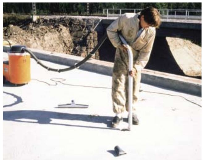
Kuva 14. Lopuksi eristysalusta puhdistetaan imuroimalla.
