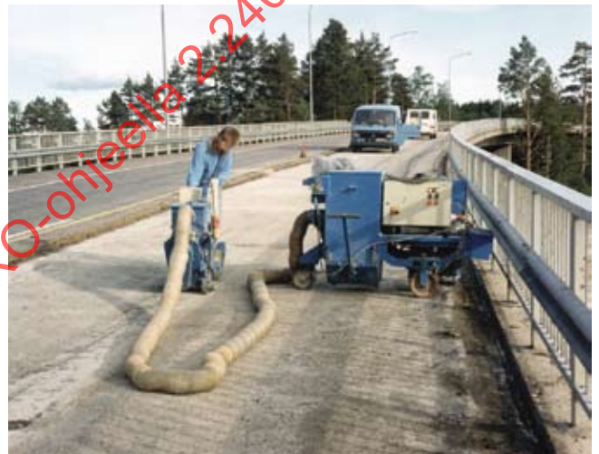
Kuva 13. Eristysalustan suihkupuhdistusta sinkopuhdistuksella.
