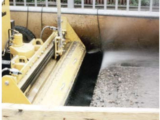
Kuva 3. Kansilaatan vesipiikkausta.
