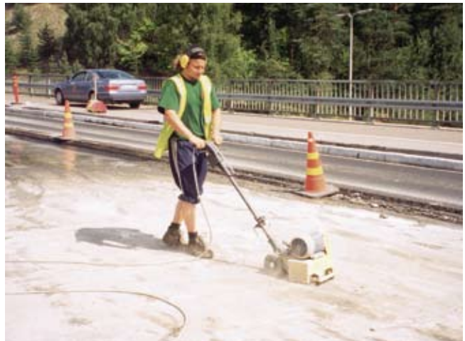
Kuva 5. Pienet alueet jyrshintään ja jälkijyrshintä tehdään kevyellä jyrsimellä.
