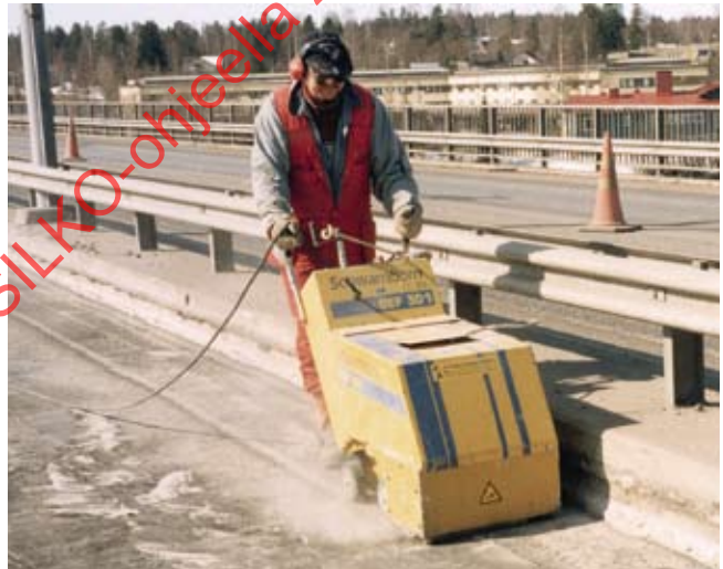
Kuva 4. Kansilaatan pintaa poistetaan voimakkaalla jyrsimellä.
