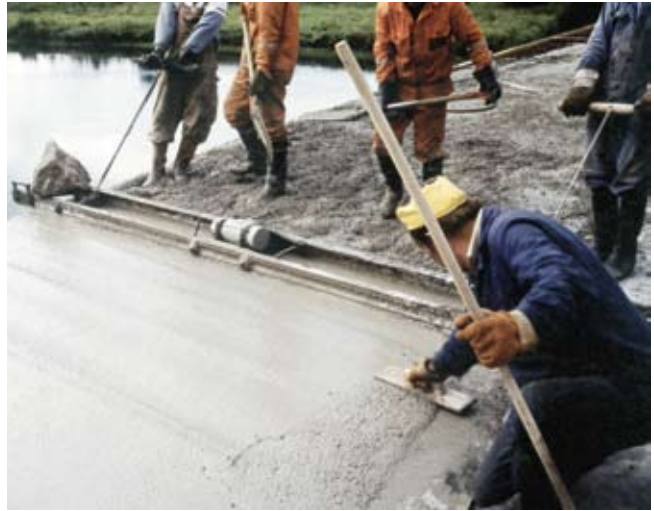
Kuva 8. Betonimassa tiivistetään tärypalkilla.
