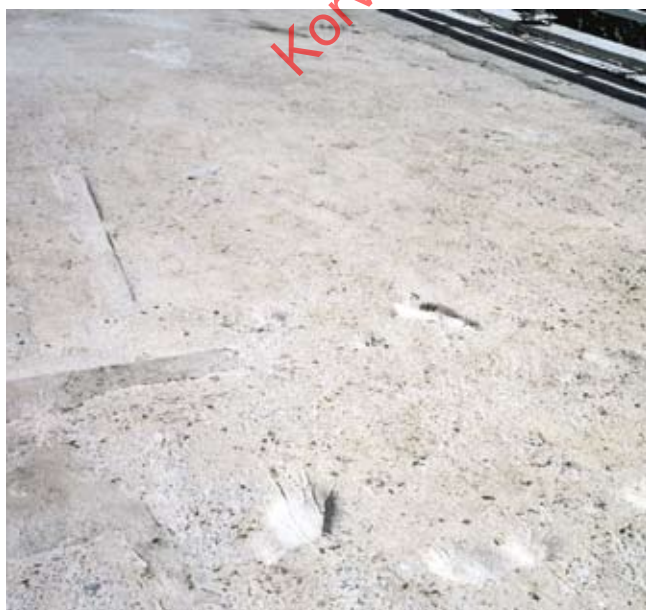
Kuva 2. Painanteita eristysalustassa.
