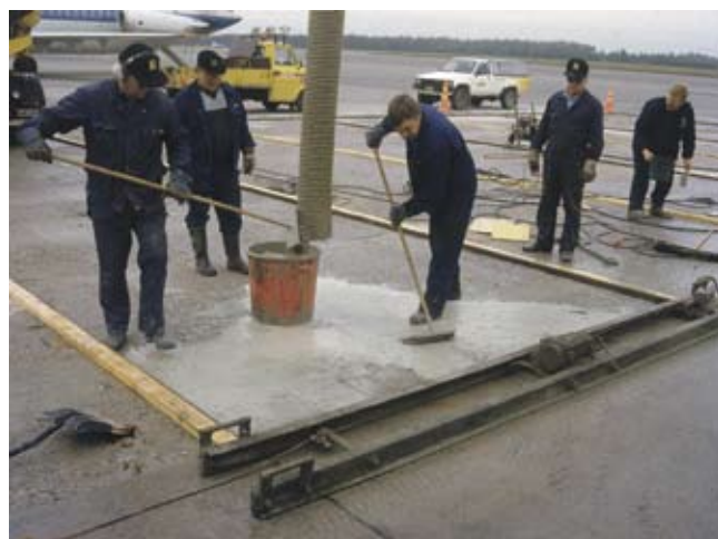
Kuva 7. Tartunta-aine levitetään harjaamalla.
