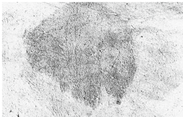
Kuva 7. Kuivasta pinnasta voidaan todeta, että haihtallinen öljy on saatu poistetuksi.
