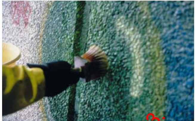
Kuva 12. Maalinpoistoaine levitetään siveltimellä.
