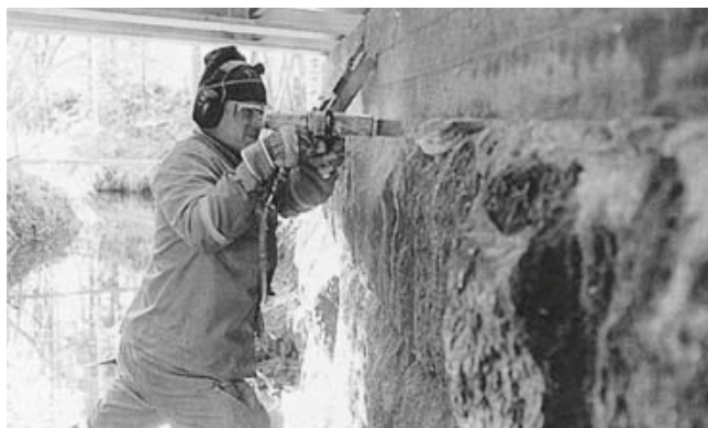
Kuva 10. Kivipintaa puhdistetaan neulahakkurilla.
