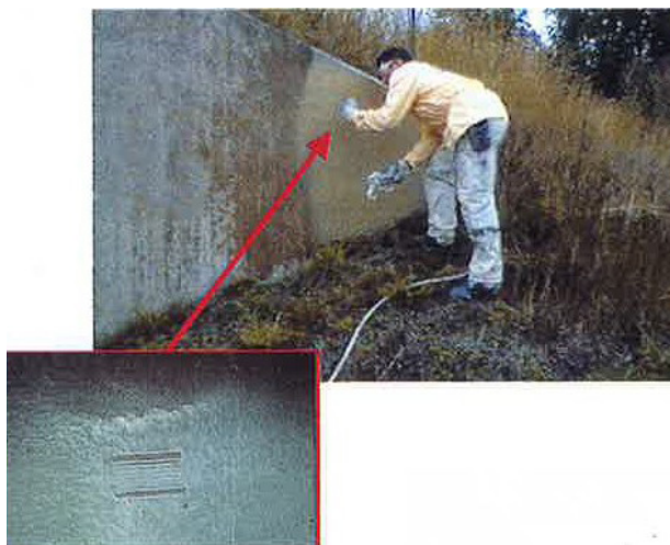
Kuva 10. Geelimäisen aineen paksuuden mittausta.
