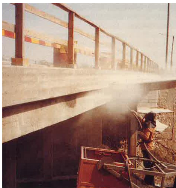
Kuva 4. Impregnoitavaa pintaa suihkupuhdistetaan.
