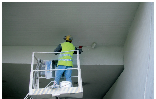
Kuva 13. Sementtipohjaisen pinnoitteen harjausta.
