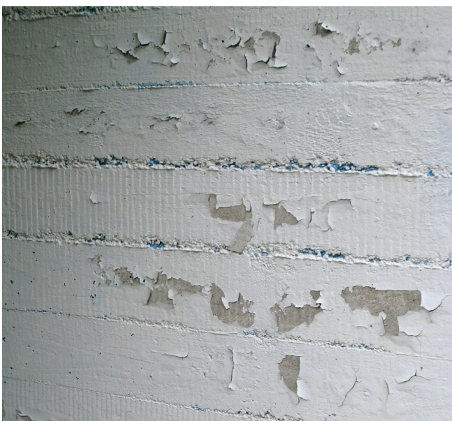
Kuva 2. Väärä pinnoitteen valinta ja työvirheet aiheuttavat pinnoitteen lohkeilua ja hilseilyä.
