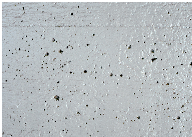
Kuva 15. Pintaan ei saa jäädä avonaisia huokosia.
