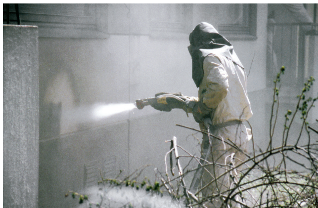
Kuva 7. Pinnan suihkupuhdistusta vesihiekkapuhalluksella.
