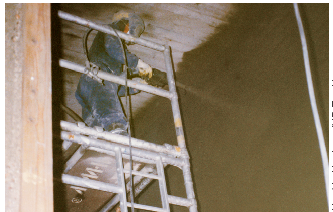
Kuva 12. Sementtipohjaisen pinnoitteen ruiskutusta.
