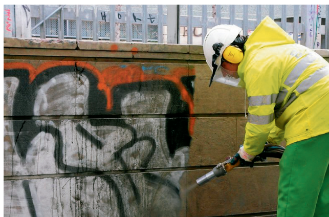
Kuva 8. Pinnan suihkupuhdistusta soodapuhalluksella.
