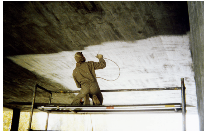
Kuva 11. Polymeripinnoitteen ruiskutusta.
