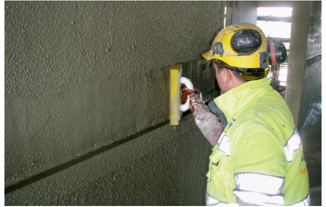
Kuva 10. Tasoituslaastin levitystä lastalla.
