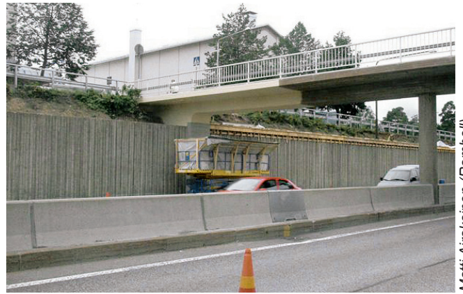
Kuva 4. Pinnoitukseen on käytetty henkilönostinta.
