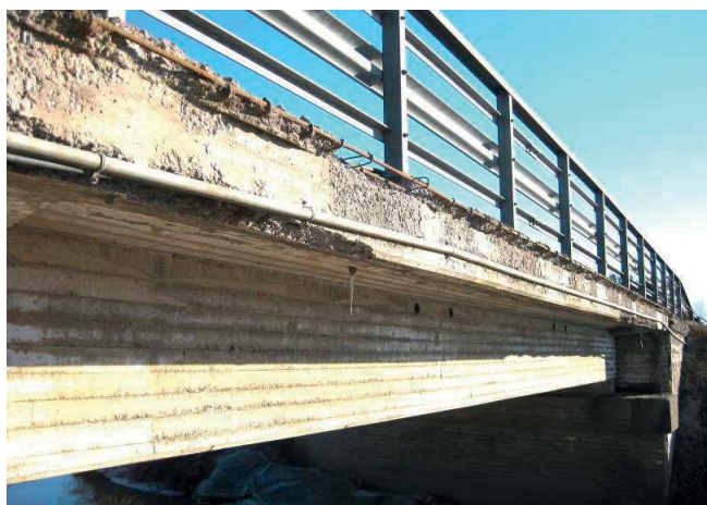
Kuva 1. Vaurioituneen reunakaistan uusiminen reunapalkkina edellyttää aina tartuntoja.
