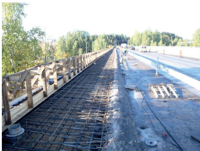
Kuva 2. Tartuntatankoja tarvitaan, kun uusi rakenneosa liitetään vanhaan.
