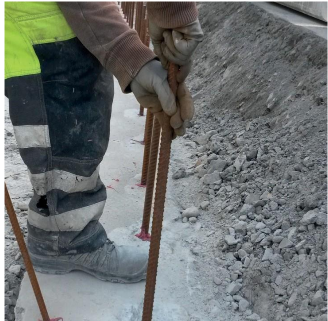
Kuva 8. Tangon asentaminen ankkurointireikään.
