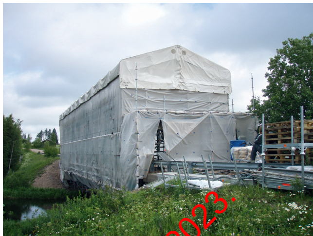
Kuva 6. Jätteiden talteenotto on järjestettävä kohteen tasoluokituksen mukaan.
