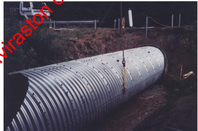
Kuva 3. Uusi teräspuutisilla sujutetaan vanhan putken sisään.
