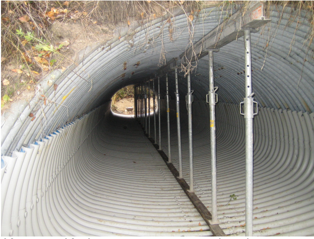
Kuva 8. Korjausosan tuenta valupainetta vastaan.
