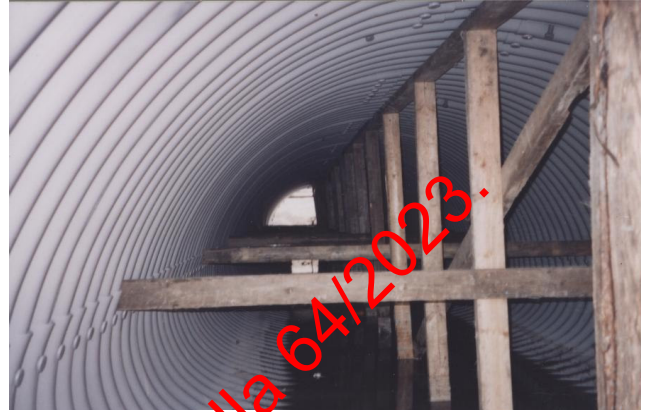
Kuva 7. Sujutusputki on tuettava betonoinnin ajaksi.
