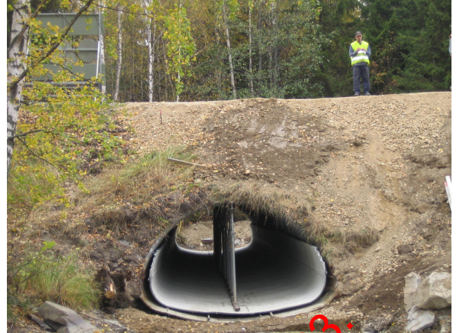
Kuva 4. Uudet teräslevyt kiinnitetään yläosastaan vanhan putken reunoihin.
