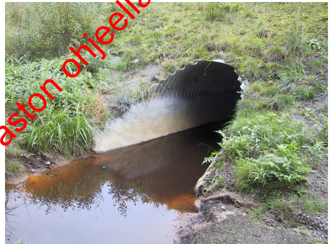
Kuva 5. Ruiskubetonoinnilla suojattu teräsputkisolta.
