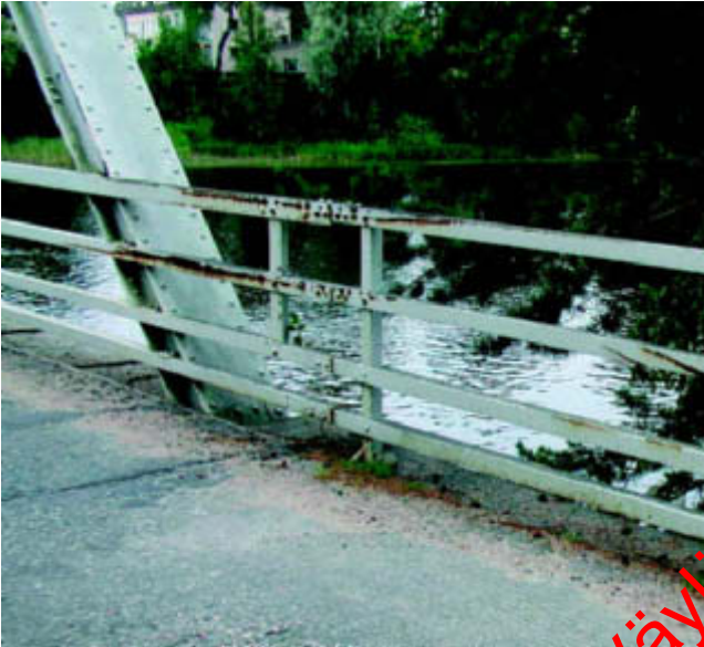
Kuva 1. Raapeet kaiteissa ovat tyypillisiä paikkausmaalauiskohteita.
