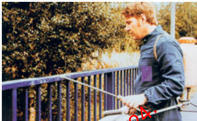
Kuva 3. Maalattavat pinnat pestään.
