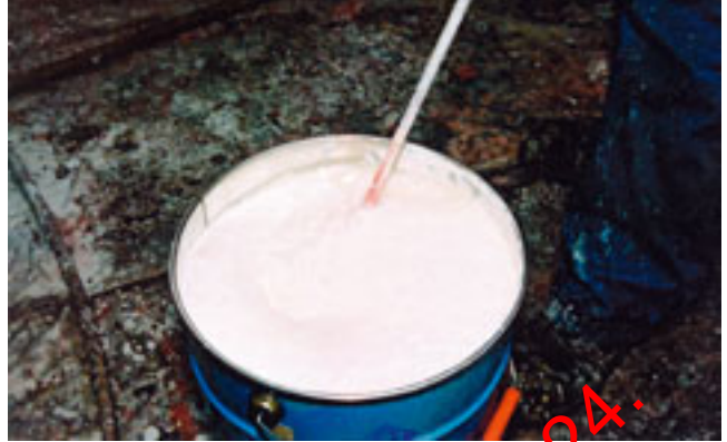
Kuva 5. Maali sekoitetaan huolellisesti.
