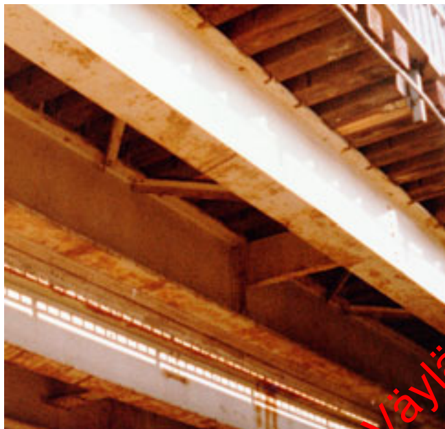
Kuva 1. Etualalla olevan palkin alapinta on ruostumisasteessa Ri3 ja taustalla olevat ruostumisasteessa Ri4.
