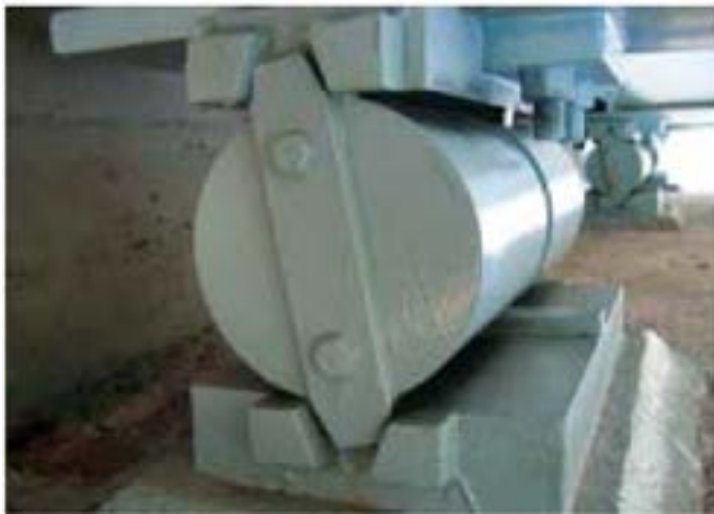
Kuva 6. Siististi tehtyjä laakerien huoltokäsittelyjä.
