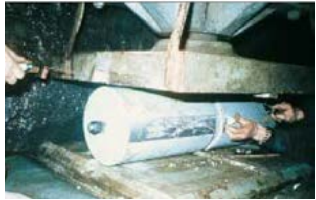
Kuva 13. Irrotetun laakerin asennusta.
