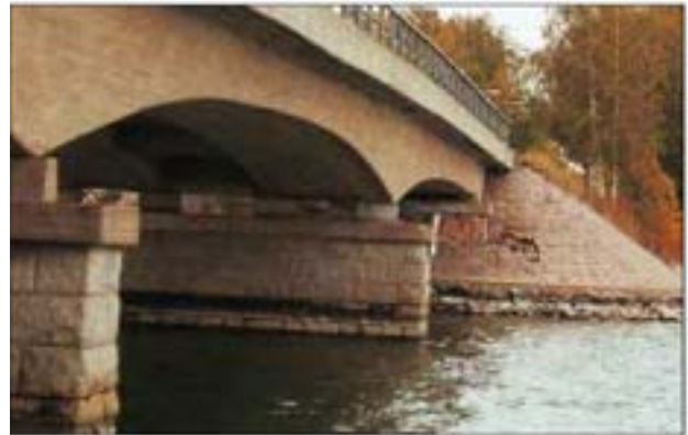
Kuva 14. Välituen laakerit on suojattu koteloilla.
