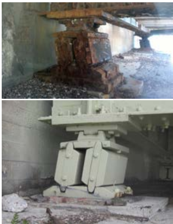
Kuva 15. Pahasti ruostunut teräslaakeri on uusittu kokonaan (U-286 Espoonlahden silta).
