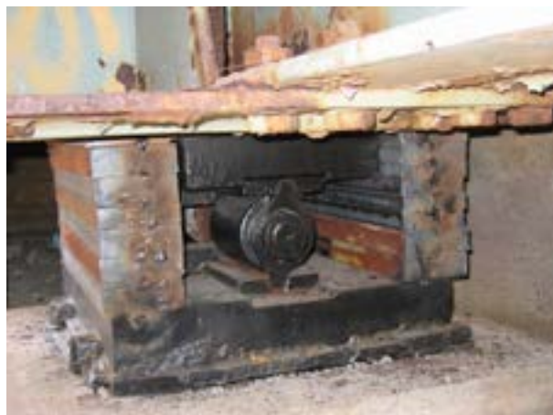
Kuva 2. Tuenta rullalaakerin vaihtoa varten (KaS-766 Keltin silta)
