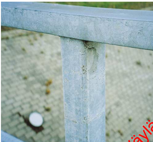
Kuva 1. Sinkkikerrosta ei saa päästää ohene- maan liiaksi.
