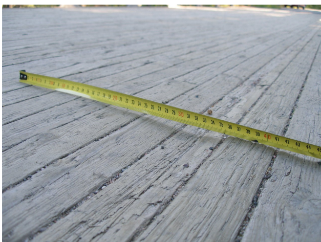
Kuva 2. Vahvennettavaksi soveltuva kulunut ja hieman pintalahonnut puukansi.
