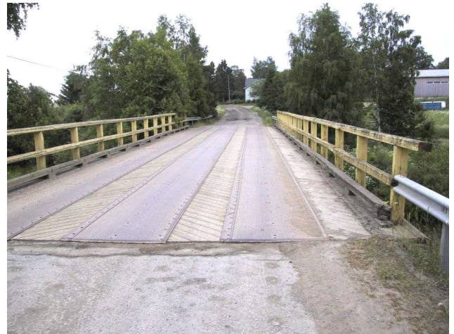
Kuva 6. Teräslevyt puukannelle asennettuina
