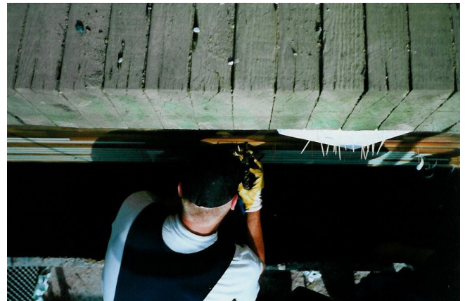
Kuva 4. Injektointia erikoissuutinta käyttäen.
