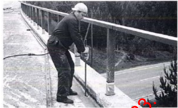
Kuva 7. Tippuputket avataan ja kunnostetaan ennen salaojan asentamista.
