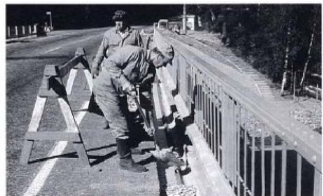
Kuva 9. Ympäristäyttö tehdään sidotusta kiviaineksesta.
