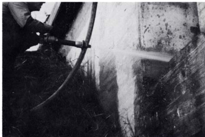
Kuva 16. Laakeritaso ja kuivatuslaitteet puhdistetaan painepesurilla
