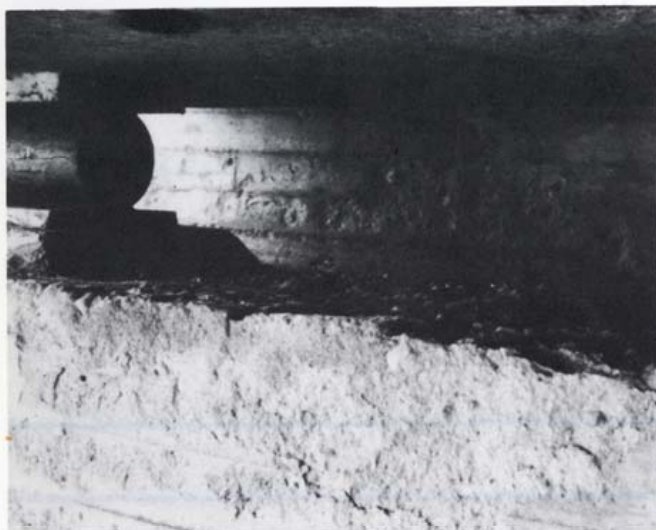
Kuva 1. Suolakorroosioaurioita laakeritasolla
