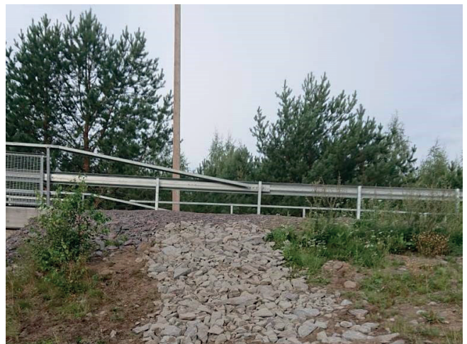
Kuva 12. Kivisuotokouru sillan päässä.
