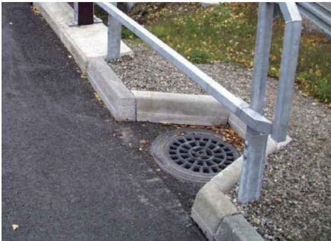
Kuva 13. Vedet ohjattu reunuksilla hulevesikaivoon.
