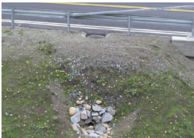
Kuva 5. Hulevesi johdettu reunusten avulla kaivoon ja putkeen.
