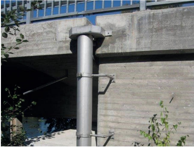
Kuva 6. Hulevesiputki liikuntasaumalaitteen päässä.
