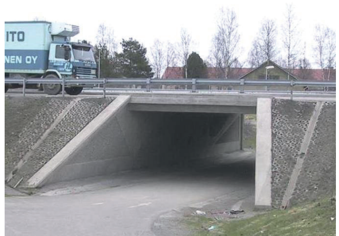
Kuva 7. Betoniset kouruelementit sivuluiskassa.
