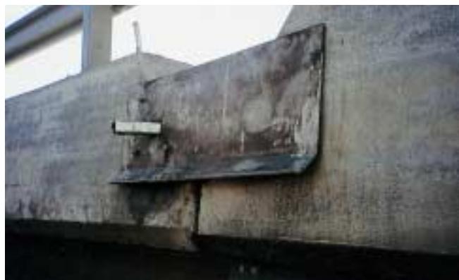
Kuva 9. Reunan tuenta (poikittaissalaoja on johdettu levyn läpi).
