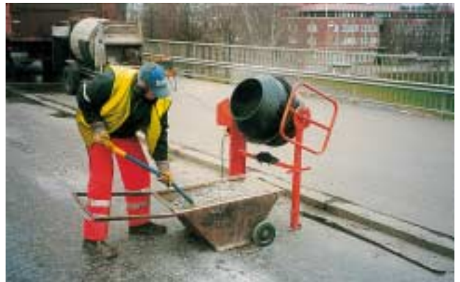
Kuva 11. Osa-aineiden sekoitusta.
