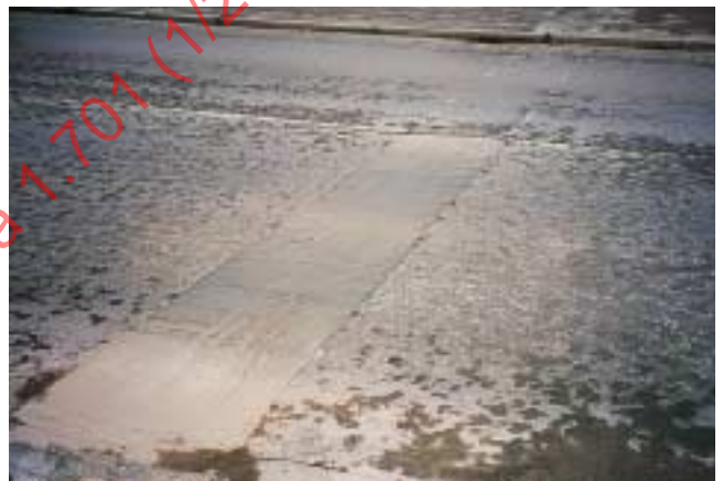
Kuva 5. Massaliikuntasauma korjaustyön alaisena (etualalla korjaustyö valmiina, seuraavalla kaistalla vielä päällysteen peitossa, jalkakäytävän saumaa ei ole tarpeen korjata).
