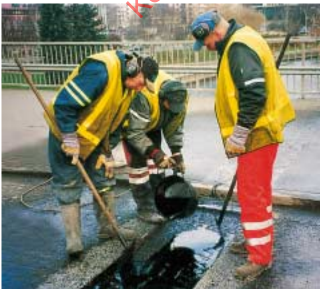
Kuva 10. Tartunta-aineen levitystä.
