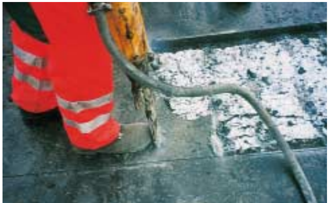
Kuva 8. Päälyste piikataan pois irrotuskaistan päältä.
