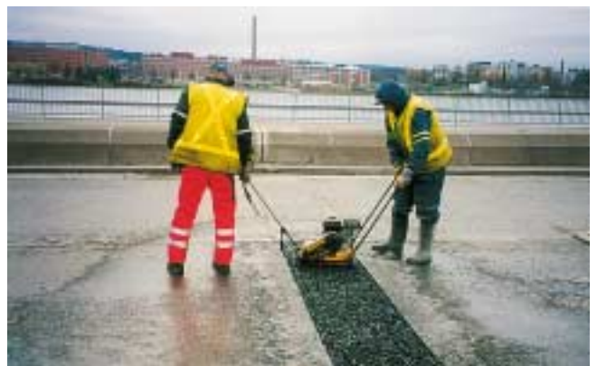
Kuva 13. Pinta tärytetään.
