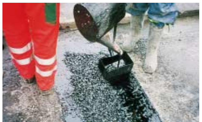
Kuva 14. Pintaan levitetään sideaine.
