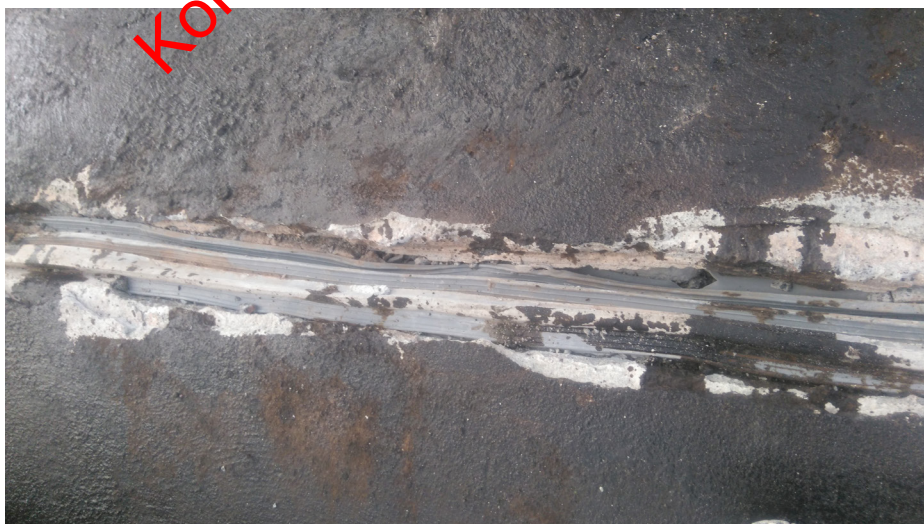
Kuva 5. Virheellisesti asennettu U-saumanauha rakenteen pinnassa. Laipat ovat nousseet puutteellisen sidonnan vuoksi.
