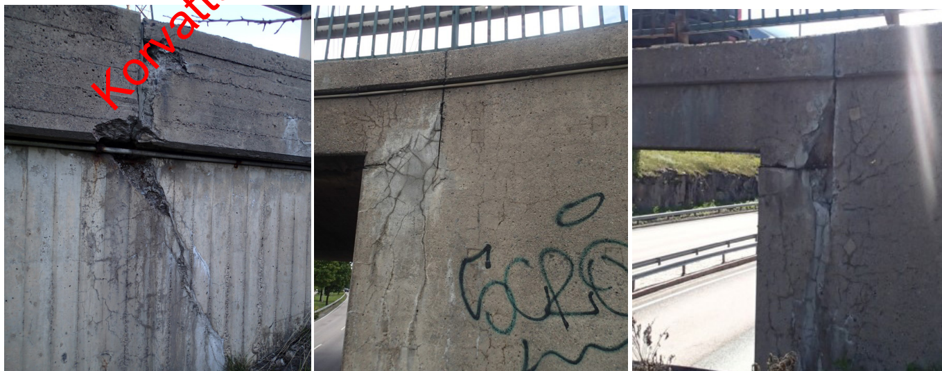
Kuva 1. Avonaisesta saumasta valuva suolainen vesi vaurioittaa alapuolisia rakenteita.
