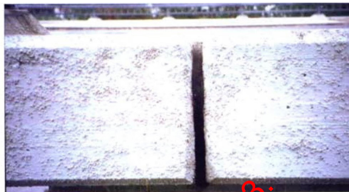
Kuva 6. Esipuristettu paisuva saumanauha.
