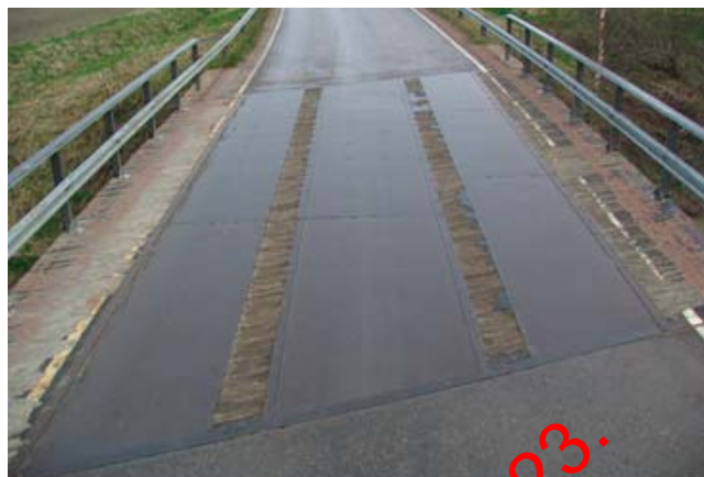
Kuva 3. Teräslevyt puukannelle asennettuina.
