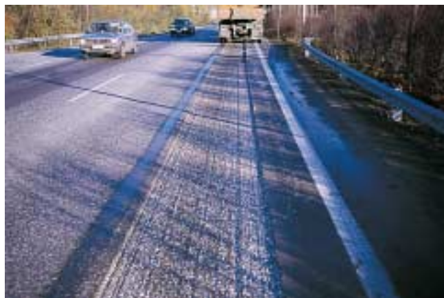
Kuva 4. Päällyste on purettu jyrsimällä (laatikkojyrsimä).
