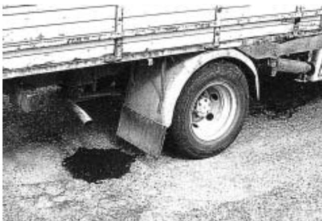
Kuva 13. Kylmämassapaikkauksen tiivistystä.
