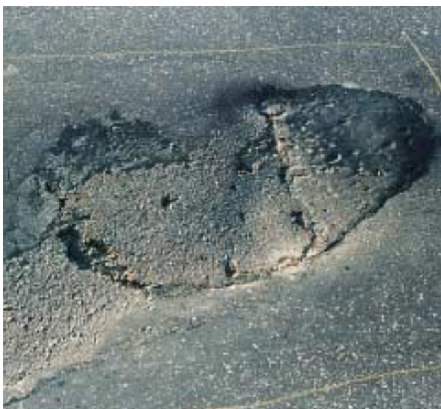
Kuva 1. Purkautunut asfalttipäällyste.
