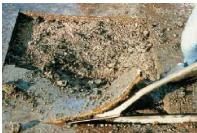
Kuva 6. Vaurioituneen päällysteen purkamista.
