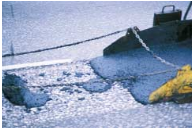
Kuva 7. Valuasfaltin levitystä kelkalla.
