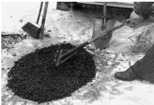
Kuva 12. Kylmä paikkausmassa levitetään käsin.
