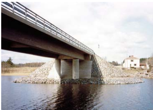
Kuva 3. Tyylikkää keilaverhoukset on tehty omalla painollaan paikallaan pysyvistä kivilaatoista.
