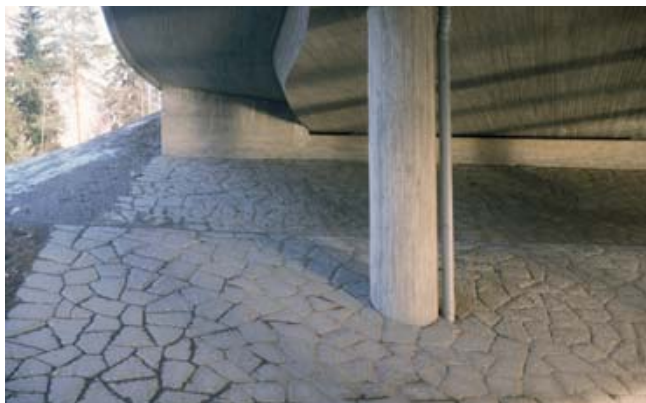
Kuva 4. Etuluiskaa elävöittävä verhoukset on tehty sideominaisuuksillaan paikallaan pysyvistä kivilaatoista.
