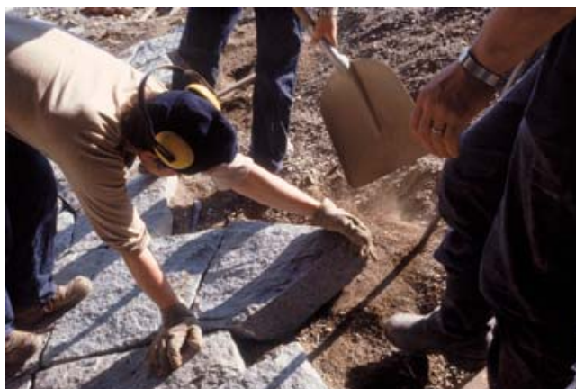
Kuva 16. Kivilaatan pitää sopia hyvin paikalleen.
