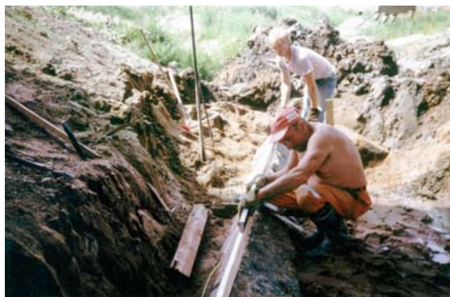
Kuva 14. Juurikivet on asennettava huolellisesti.
