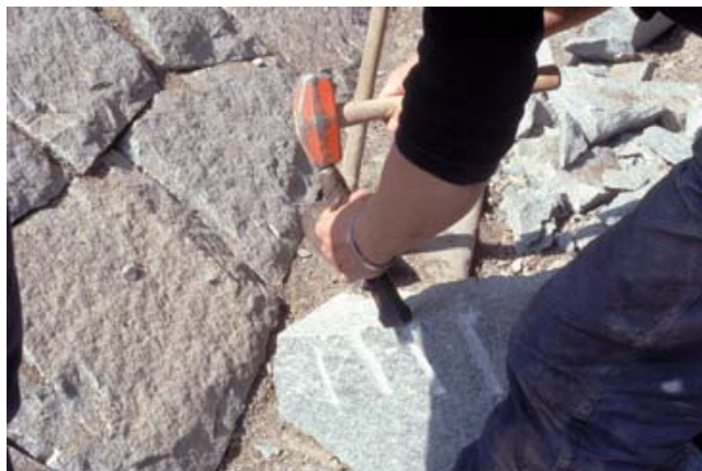
Kuva 15. Kivilaatan viimeistelyä.
