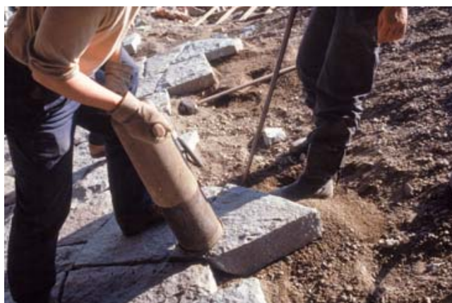
Kuva 17. Kiven alusta on tiivistettävä.
