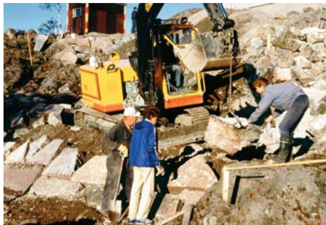
Kuva 13. Verhoustyön nostot ja siirrot tehdään mahdollisuuksien mukaan konetyönä.
