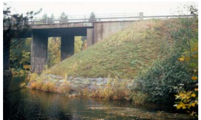
Kuva 6. Palkkiverhous keilan alaosa.
