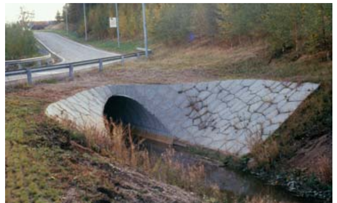
Kuva 7. Tiivissaumainen verkkoverhous.
