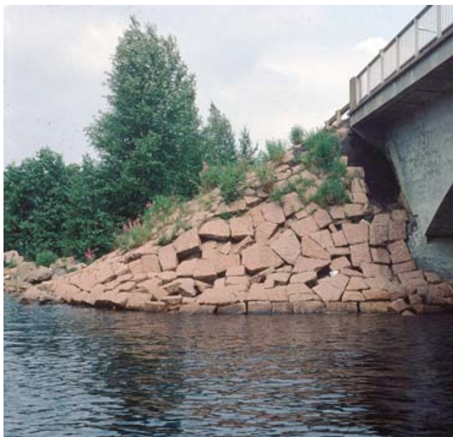
Kuva 1. Kivilaattaverho on sortunut.
