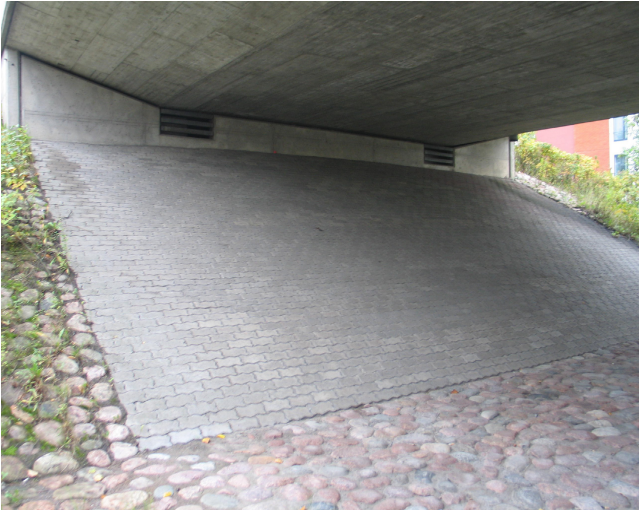
Kuva 1. Umpinainen betonikiviverhous etuluiskassa.
