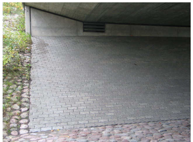
Kuva 7. Maakostean betonisiin asennettu kenttäkivi-verhous toimii betonikiviverhouksen reunavahvennuk-sena.
