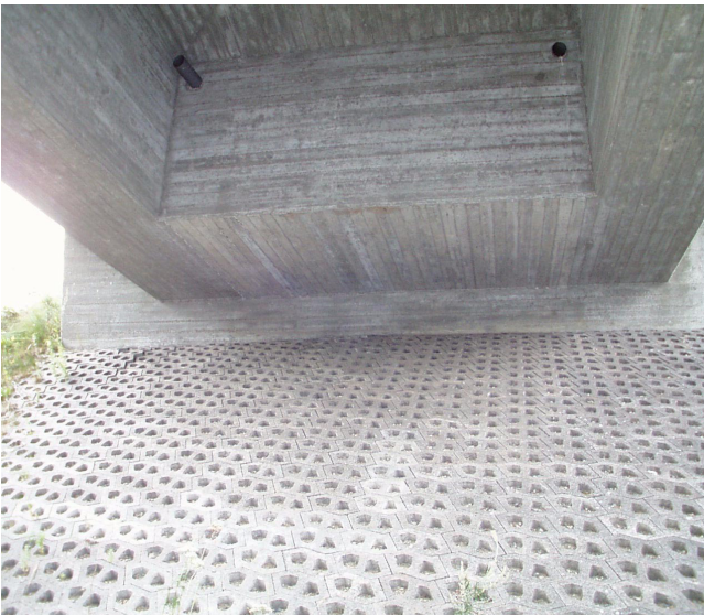
Kuva 2. Reikäkiviverhous etuluiskassa.
