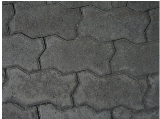
Kuva 3. Uni-kivi on siltapaikan verhouksissa yleisimmin käytetty sidekivi.
