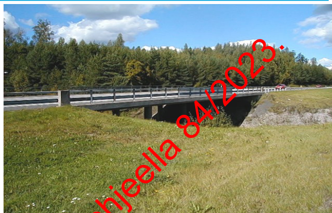
Kuva 3. Luiskat on muotoiltava loiviksi.
