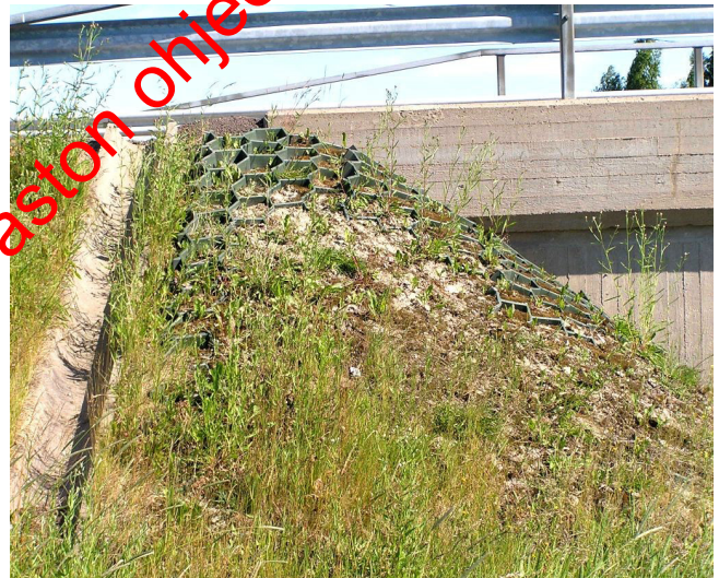
Kuva 7. Luiskakennojen pitäisi olla syvemmissä ja mullalla täytetyt.
